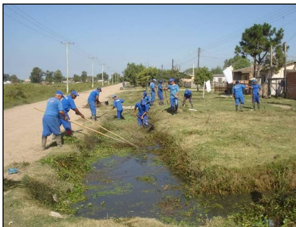
Figura 3.33 – Limpeza de valetas
