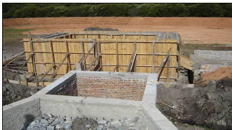
Figura 3.2 – Construção de caixa de passagem e filtro anaeróbio para o sistema de tratamento de lixiviado
