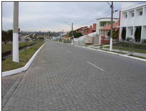
Figura 3.31 – Meio-fio após serviço de pintura
