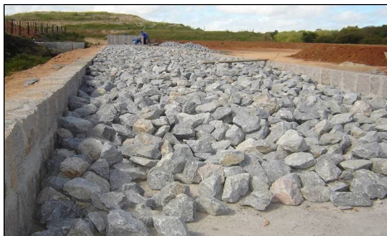
Figura 3.3 – Construção do filtro aeróbio para tratamento de lixiviado
