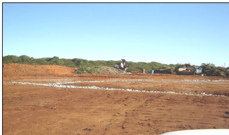
Foto 3.5 – Lançamento do sistema de drenagem de chorume
