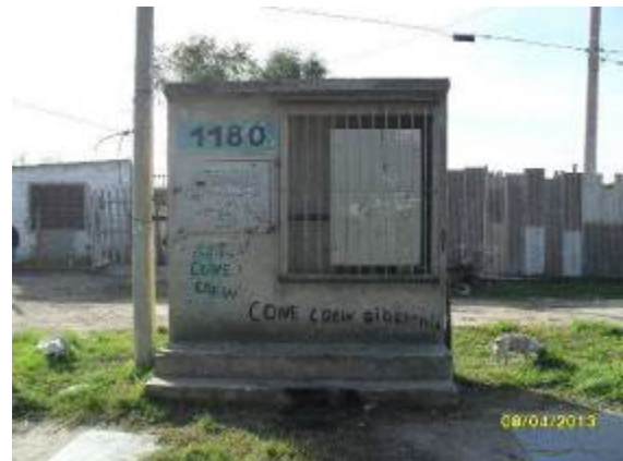
Quadro de comando ELE – L4. (Fonte SANEP)
