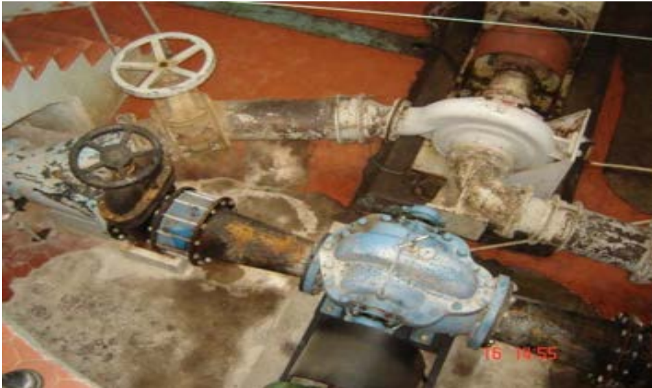
Ilustração 31 - Conjunto motobomba 3ª EEAT
