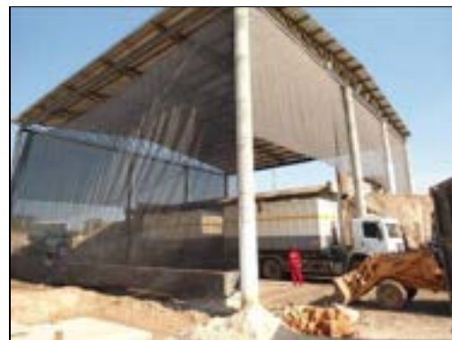
Figura 5.18 – Vista do transbordo
