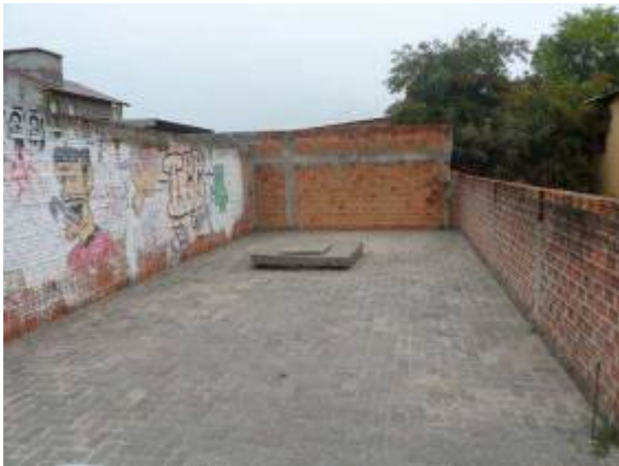
Local da Elevatória Toussaint (desativada). (Fonte SANEP)
