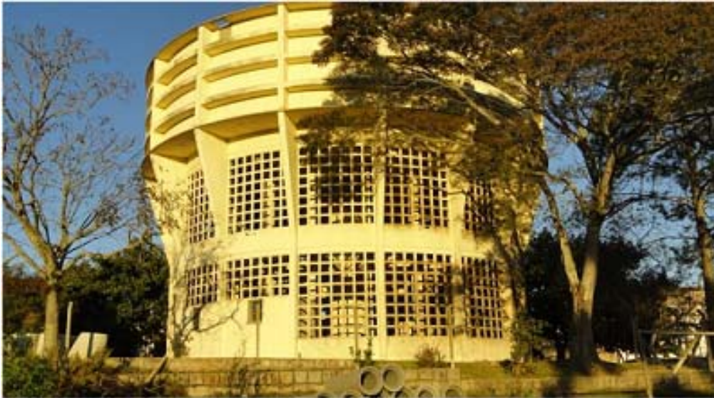
Ilustração 011 – Vista geral do Reservatório R-3.
