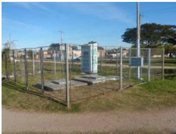
Local da Elevatória Meneghetti. (Fonte SANEP).
