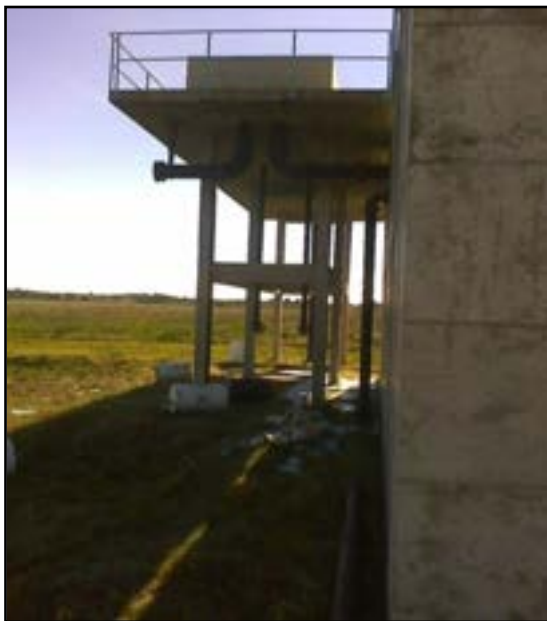
Figura 26 – Desarenador (Fonte STE)
