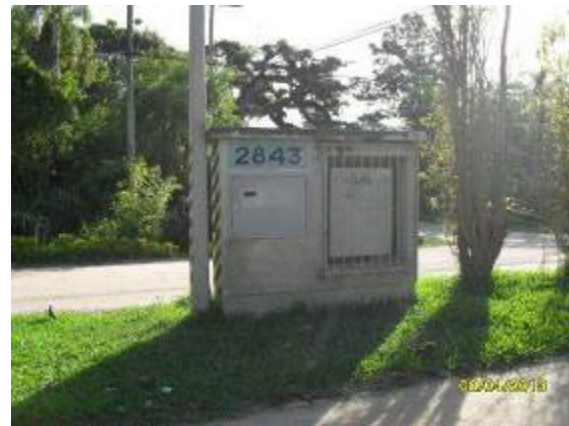
Quadro de comando ELE - L2. (Fonte SANEP)
