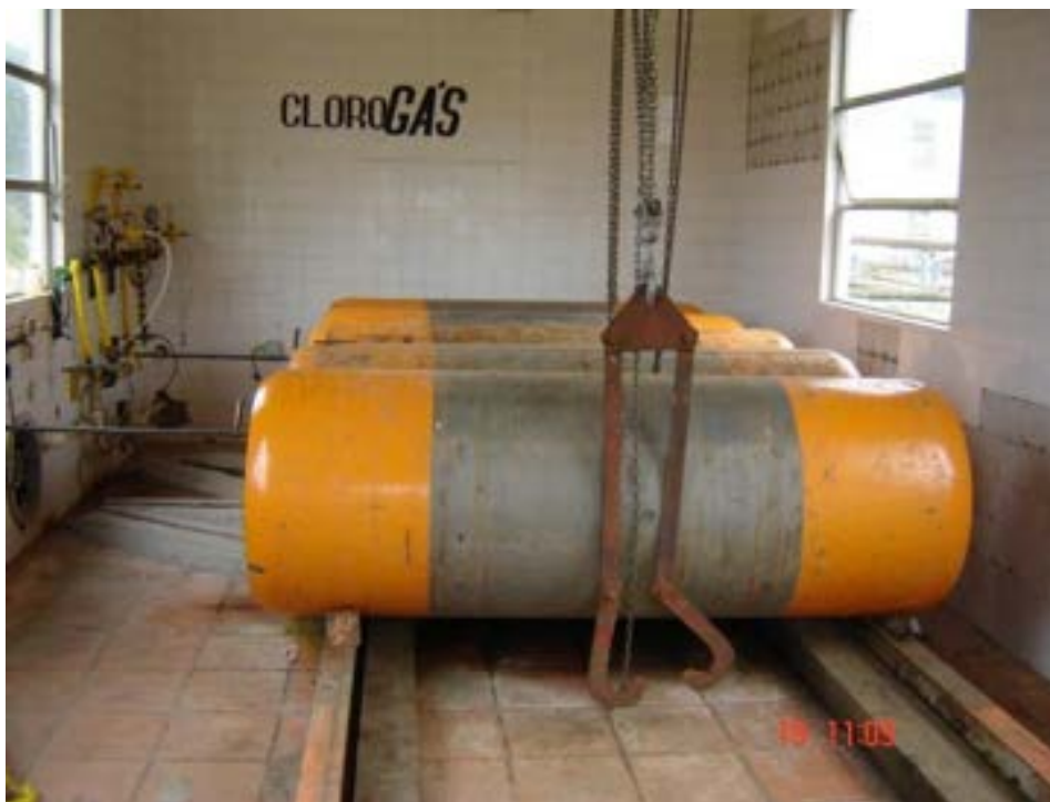
Ilustração 45 - Cilindros de cloro
