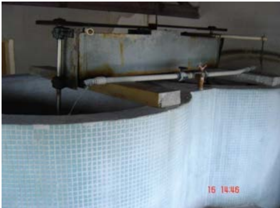
Ilustração 27 - Misturador de flúor
