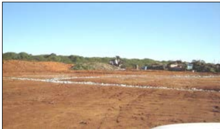
Foto 3.5 – Lançamento do sistema de drenagem de chorume
