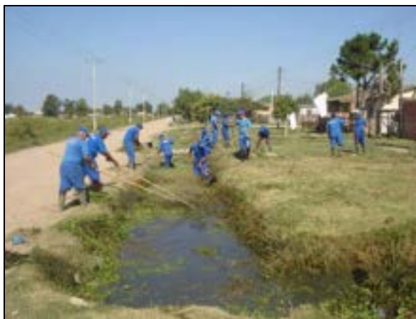
Figura 3.33 – Limpeza de valetas
