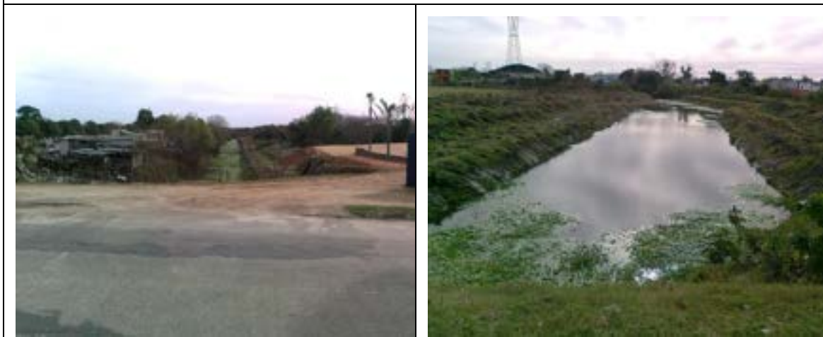
Figura 27: Vila Castilho, ponto crítico de alagamento.
