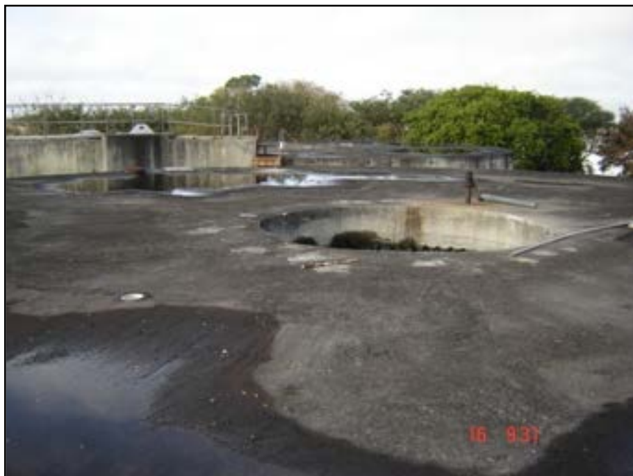
Figura 19 - Vista superior dos reatores (Fonte STE)
