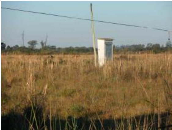
Local da Elevatória Ceval. (Fonte SANEP)
