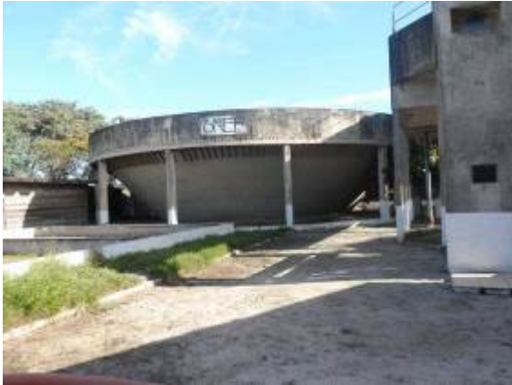
Elevatória US-III - RALF. (Fonte SANEP)
