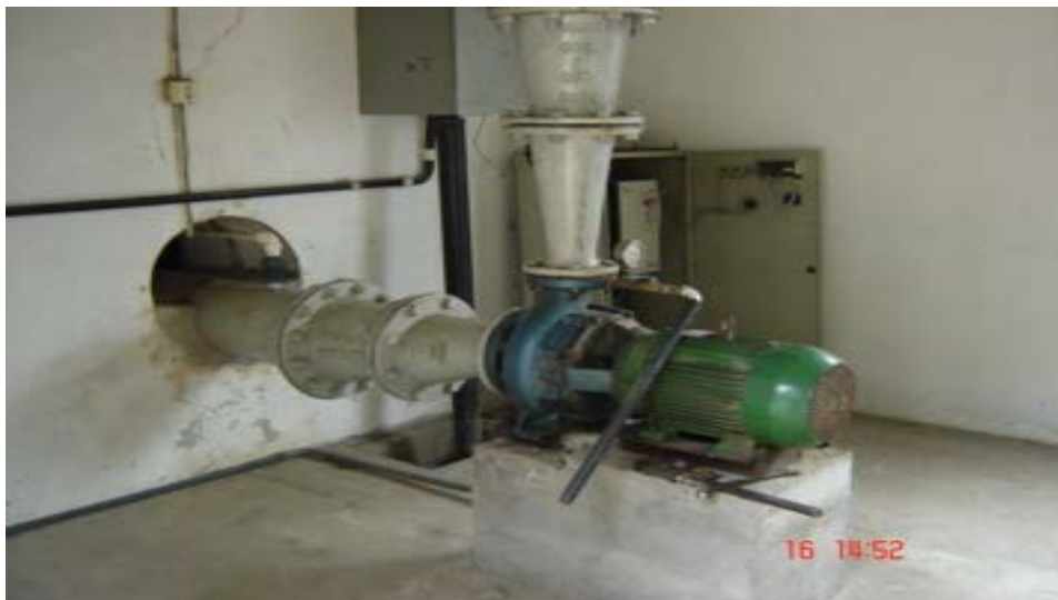
Ilustração 30 - Conjunto motobomba 2ª EEAT
