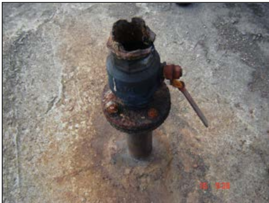
Figura 21 - Queimador de gás desativado (Fonte STE)
