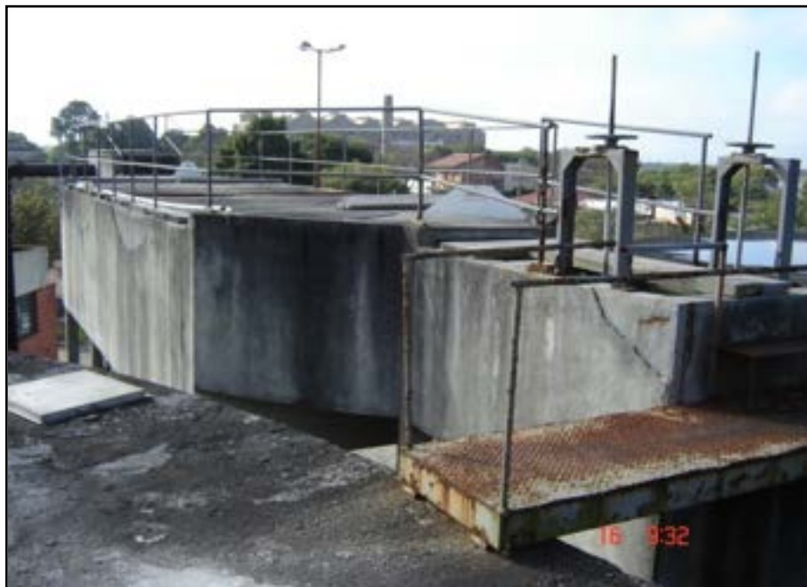
Figura 17 - Desarenador e calha Parshall (Fonte STE)
