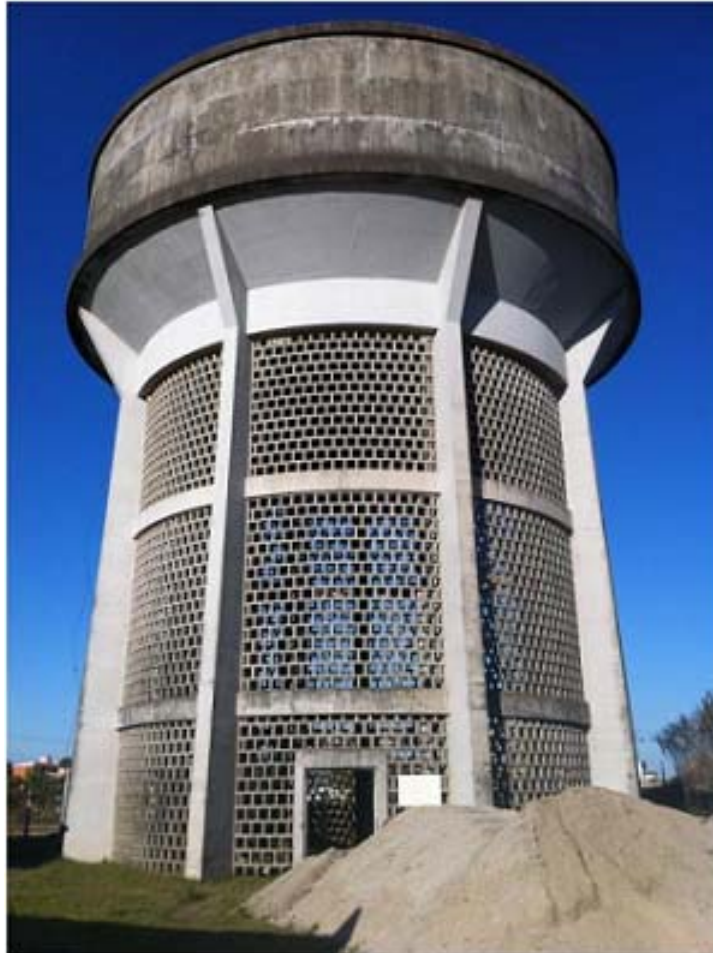
Ilustração 04 – Vista frontal do Reservatório R8.
