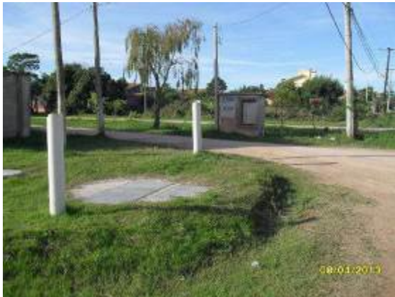
Local da Elevatória L3. (Fonte SANEP)
