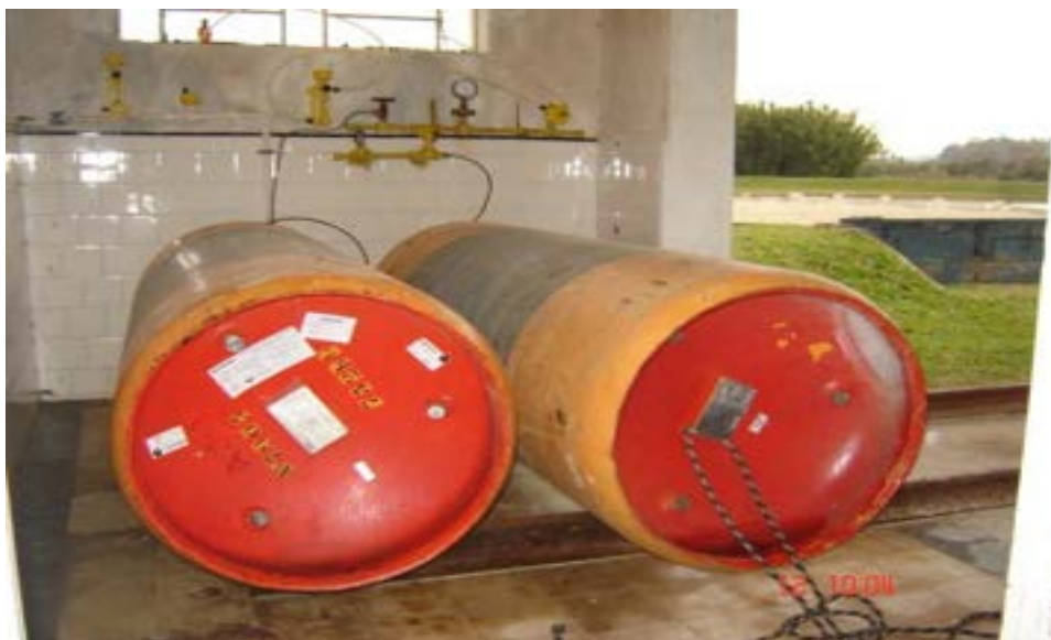
Ilustração 09 – Cilindros de Cloro
