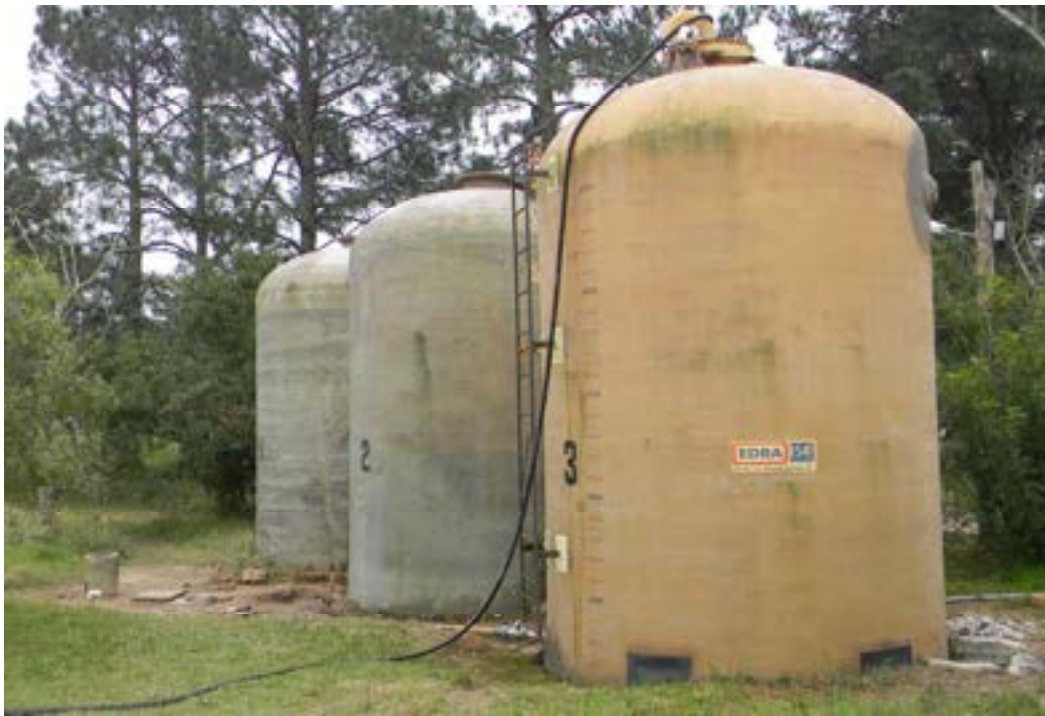
Ilustração 42 – Tanques de PAC
