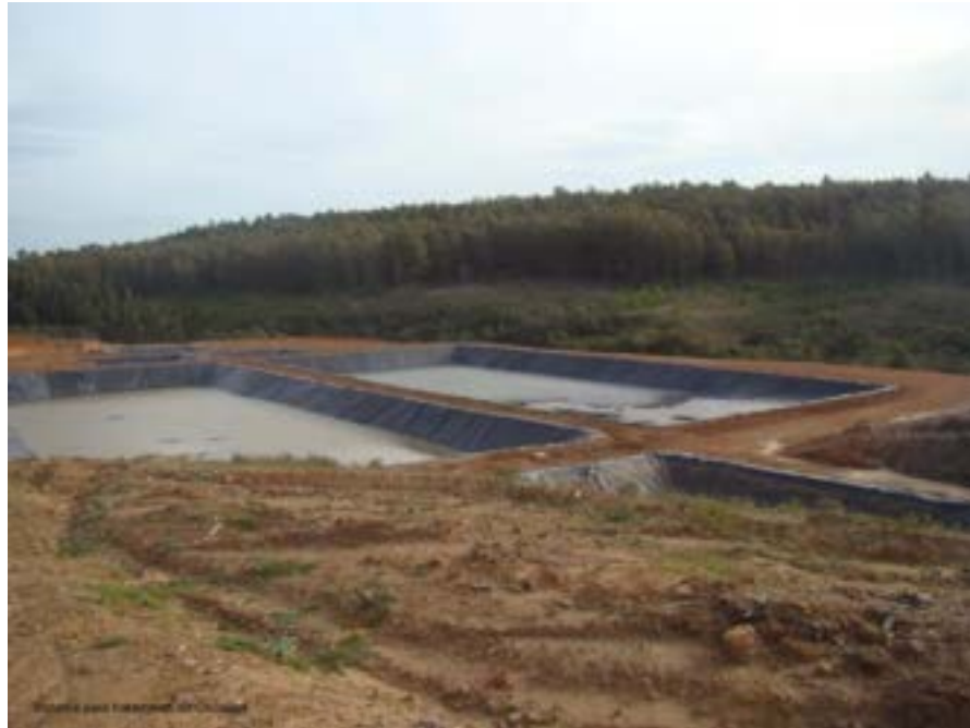
Figura 3.43 – Lagoas de estabilização para tratamento dos lixiviados
