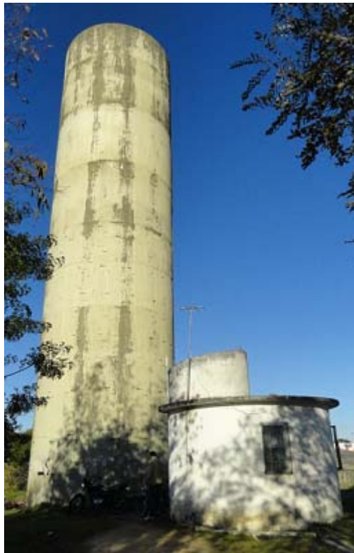
Ilustração 08 – Vista frontal do Reservatório Lindóia.
