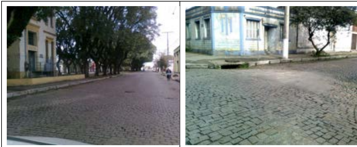
Figura 11: Dispositivos de microdrenagem superficial
