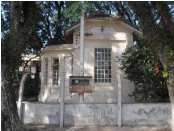
Elevatória Saldanha Marinho US-II. (Fonte SANEP)
