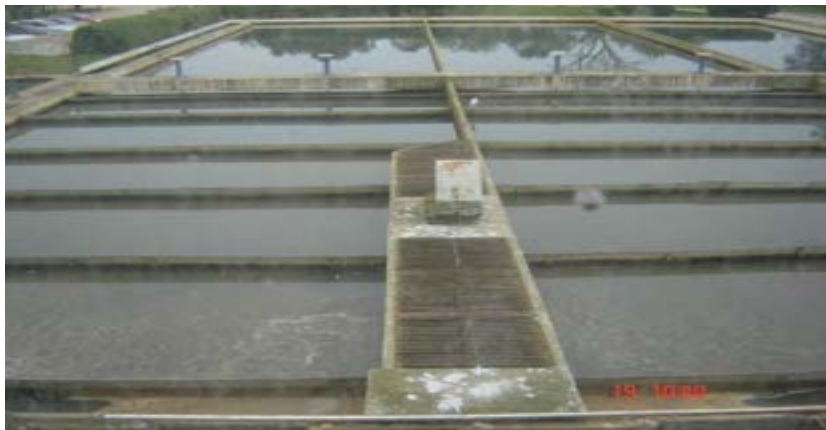
Ilustração 37 – Vista geral dos 06 decantadores da 1ª etapa
