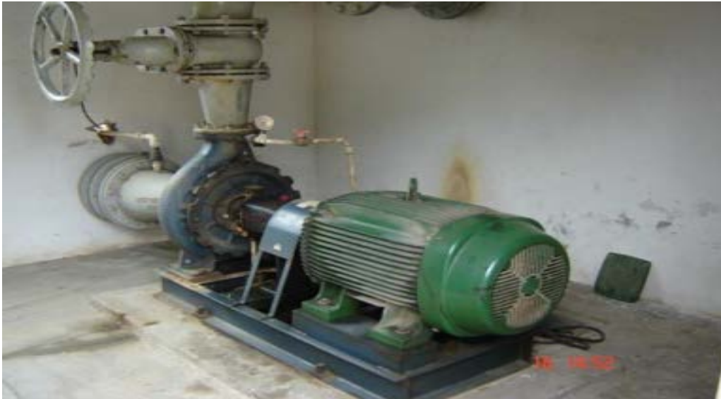
Ilustração 29 - Conjunto motobomba 1ª EEAT
