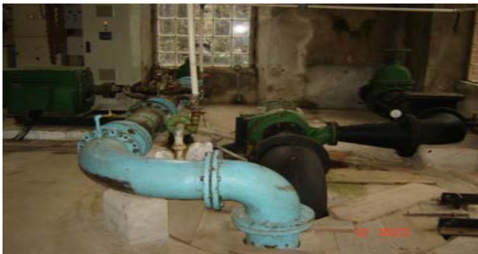
Ilustração 13 - Motores, bombas, tubulação e poço de sucção
