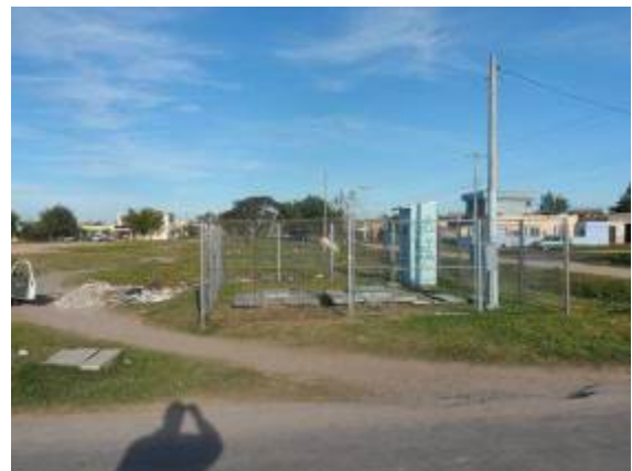
Quadro de comando ELE – Meneghetti. . (Fonte SANEP)
