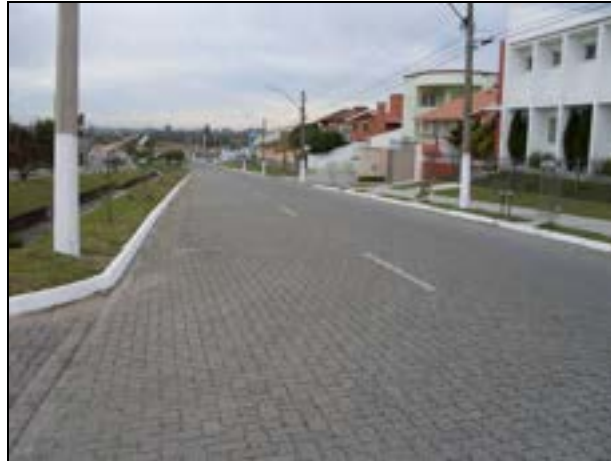
Figura 3.31 – Meio-fio após serviço de pintura
