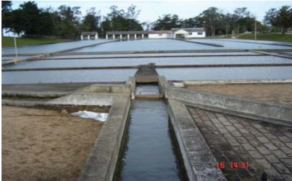
Ilustração 24 - Pré-filtros e decantadores
