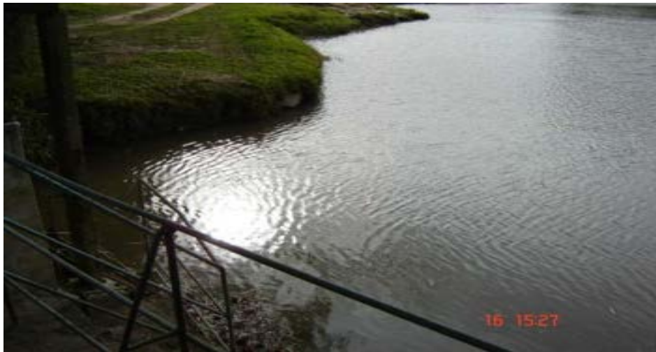
Ilustração 16 - Tomada de água Arroio Pelotas
