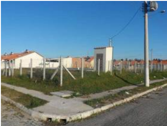
Local da Elevatória Eldorado. (Fonte SANEP)
