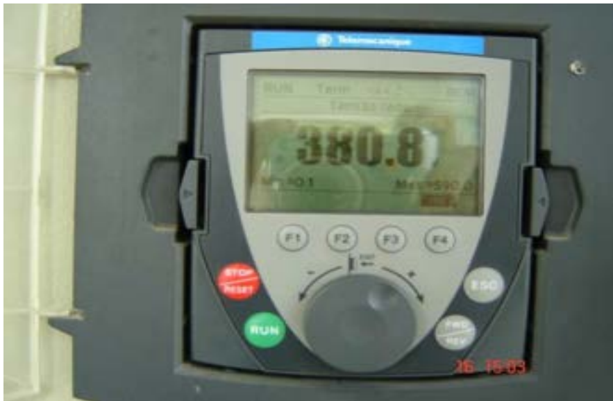
Ilustração 33 - macro medição adutora 4ª EEAT
