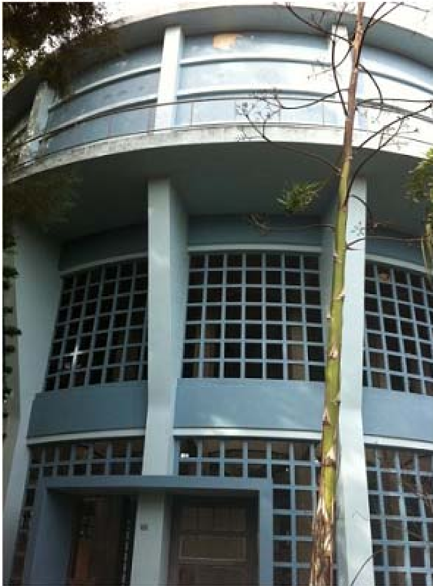
Ilustração 02 – Vista frontal do Reservatório R4.
