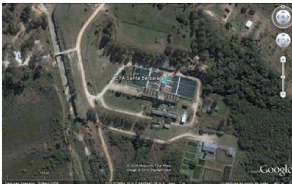
Ilustração 34 – Vista da ETA Santa Barbara
