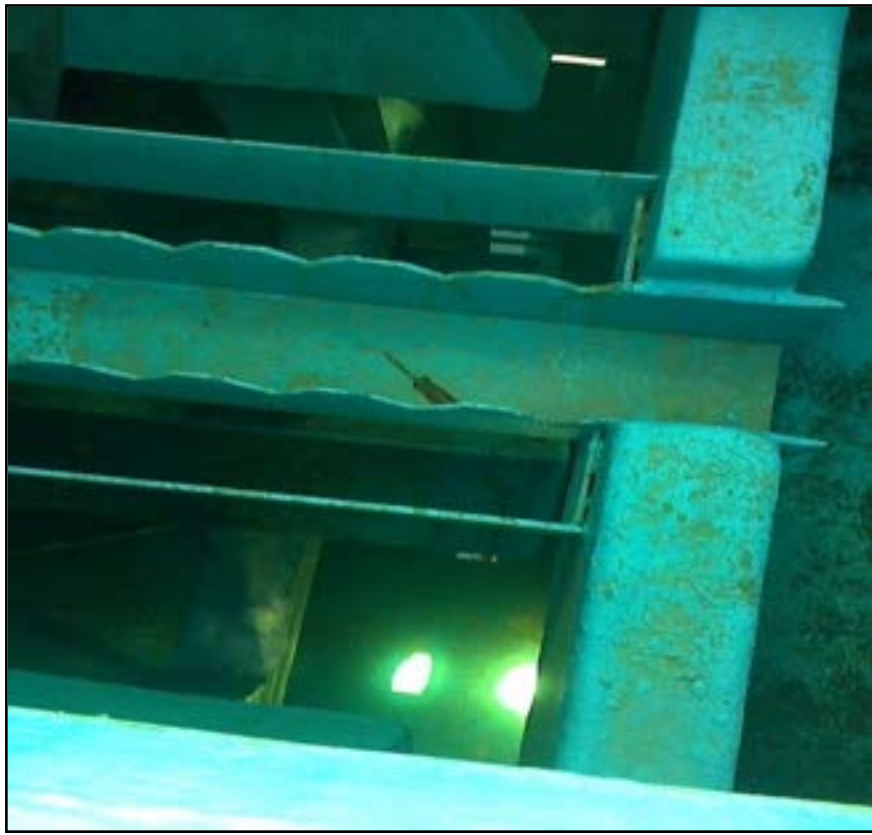
Figura 30 - Calhas internas dos reatores (Fonte STE)
