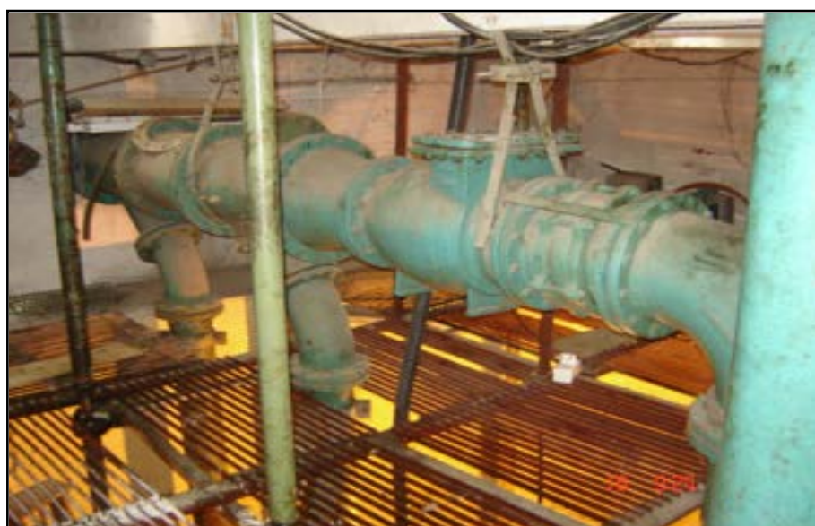
Figura 13 - Barrilete de recalque (Fonte STE)
