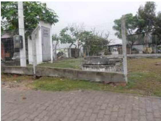
Local da Elevatória Ceval. (Fonte SANEP)
