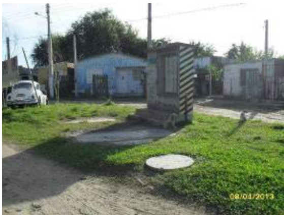
Local da Elevatória L4. (Fonte SANEP)
