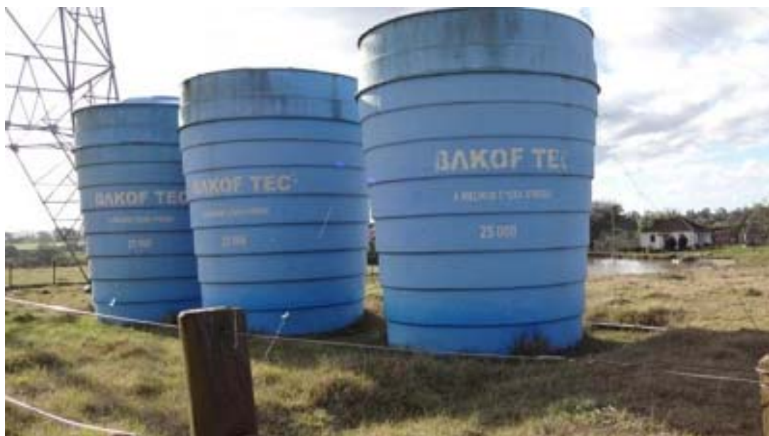
Ilustração 024 – Vista dos reservatórios, localizados na Colônia Corrientes.
