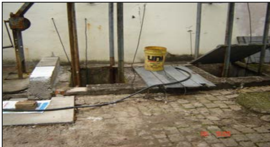
Figura 11 - Chegada do efluente na ETE (Fonte STE)
