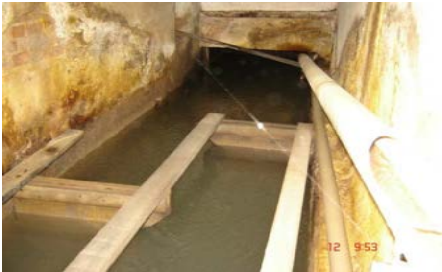
Ilustração 6 – Calha de mistura com chicanas
