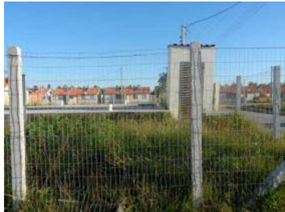
Quadro de comando ELE – Eldorado. (Fonte SANEP)
