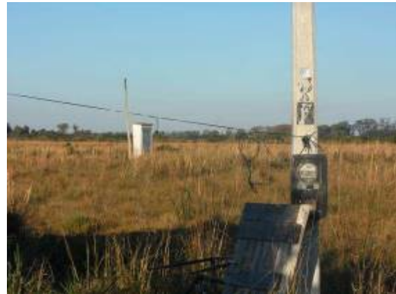
Quadro de comando ELE – Ceval. (Fonte SANEP)
