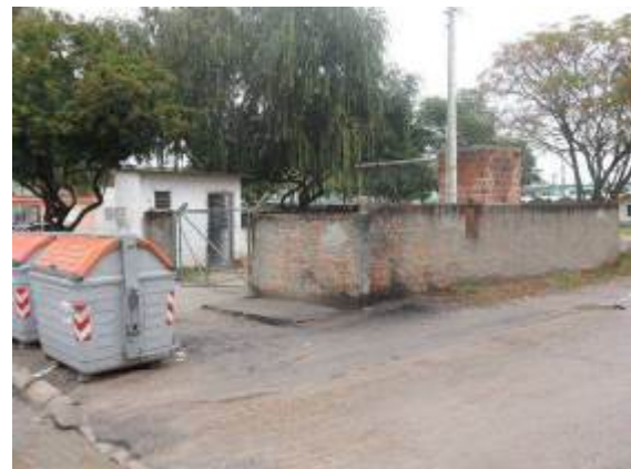
Quadro de comando ELE – Guabiroba. (Fonte SANEP)
