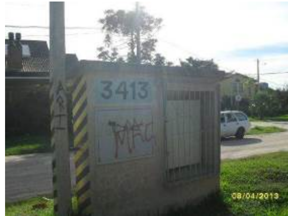
Quadro de comando ELE - L1. (Fonte SANEP)
