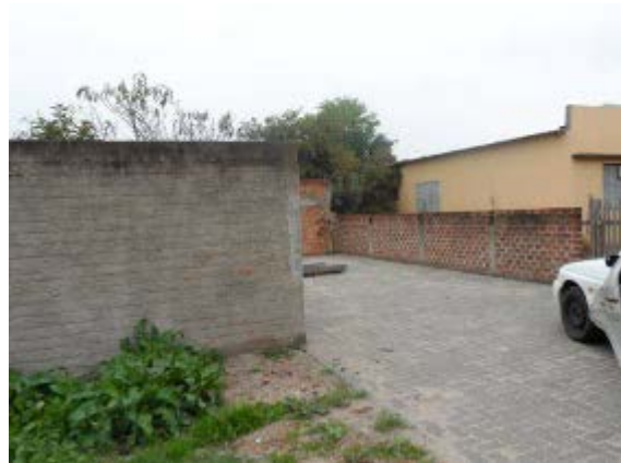
Entrada ELE – Toussaint (desativada). (Fonte SANEP)
