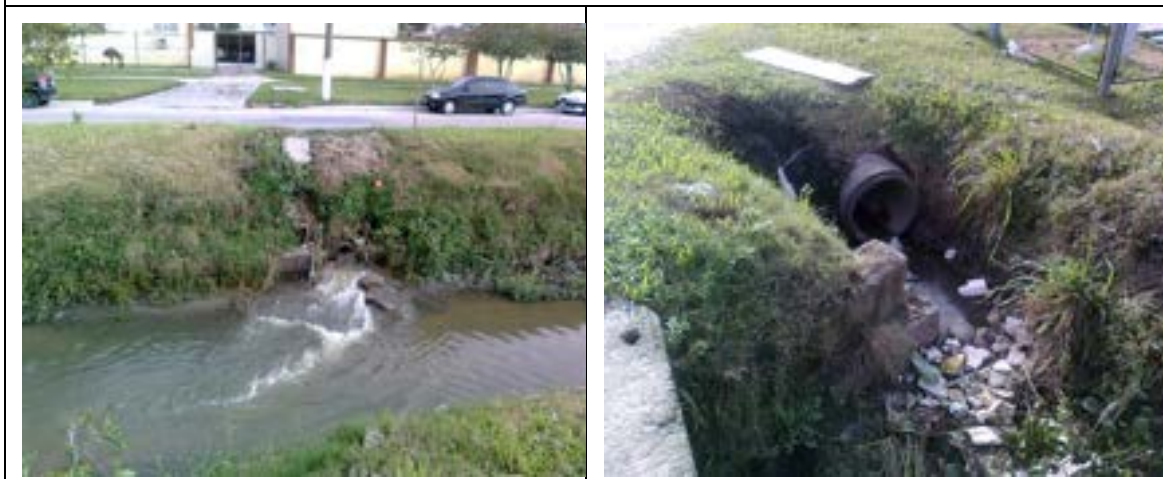
Figura 12: Microdrenagem descarregando na macrodrenagem
