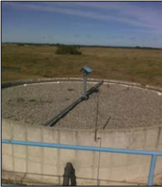
Figura 32 - Vista superior do filtro biológico (Fonte STE)
