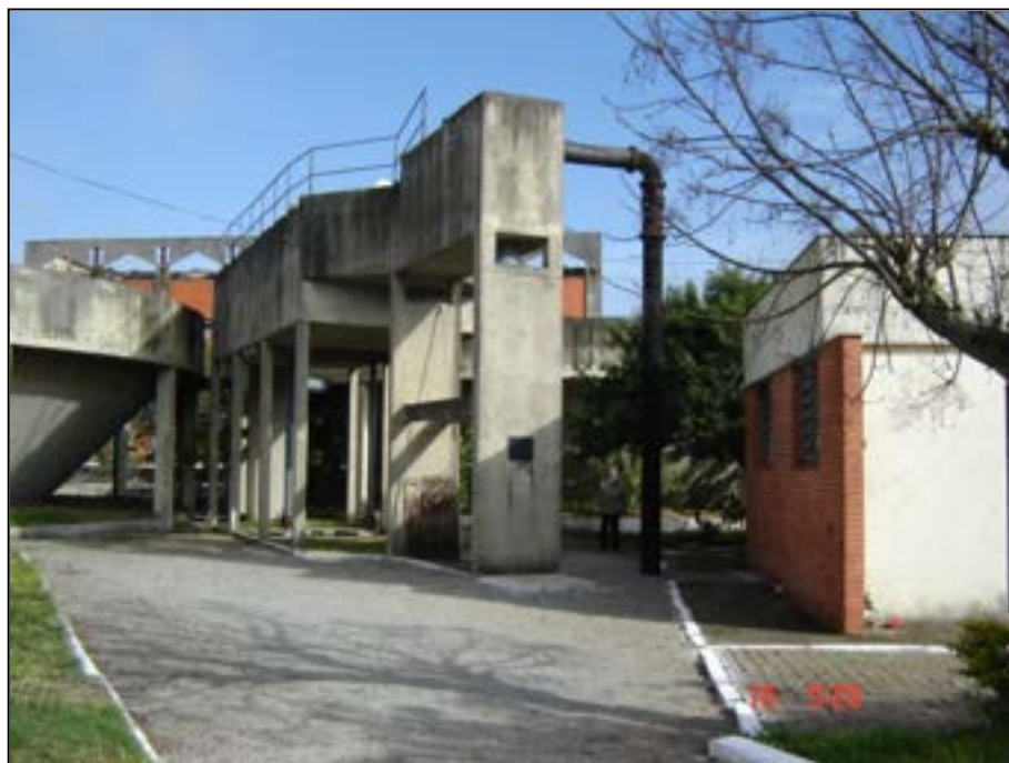
Figura 15 - Vista da estrutura de entrada (desarenador e Calha Parshall), com os dois reatores ao fundo. (Fonte STE)
