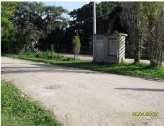
Local da Elevatória L2. (Fonte SANEP)
