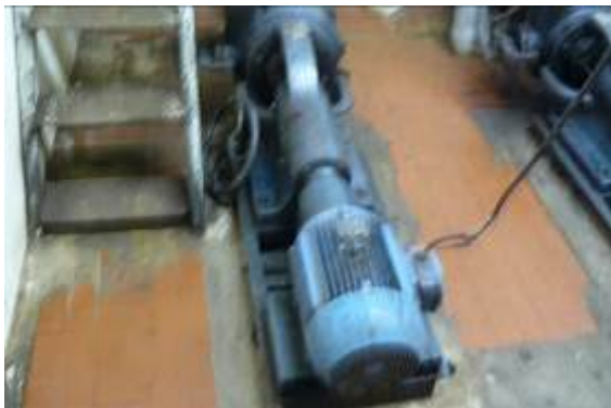
Motores Elevatória Saldanha Marinho US-II . (Fonte STE)
