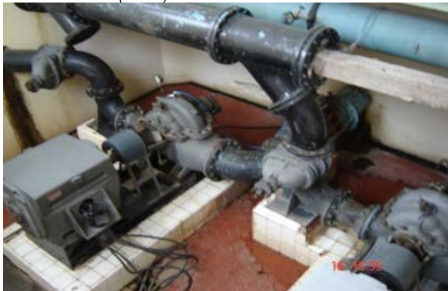
Ilustração 18 - Vista dos conjuntos motobomba 300 mm
