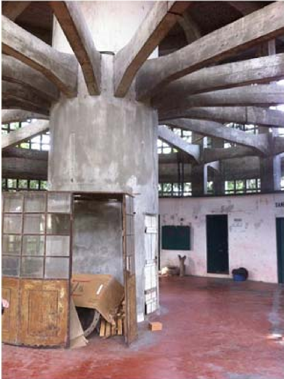
Ilustração 03 – Interior do Reservatório R4.
