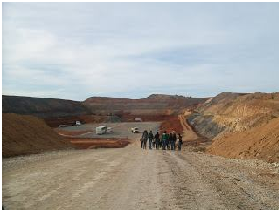
Figura 3.42 – Vista do aterro sanitário Candiota
