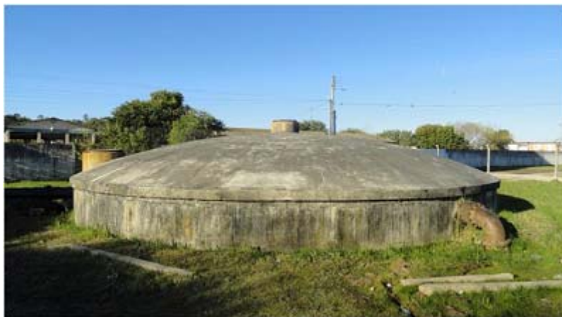
Ilustração 09 – Vista frontal do Reservatório inferior, semi-enterrado.
