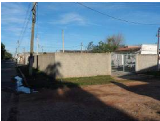
Local da Elevatória Navegantes. (Fonte SANEP)
