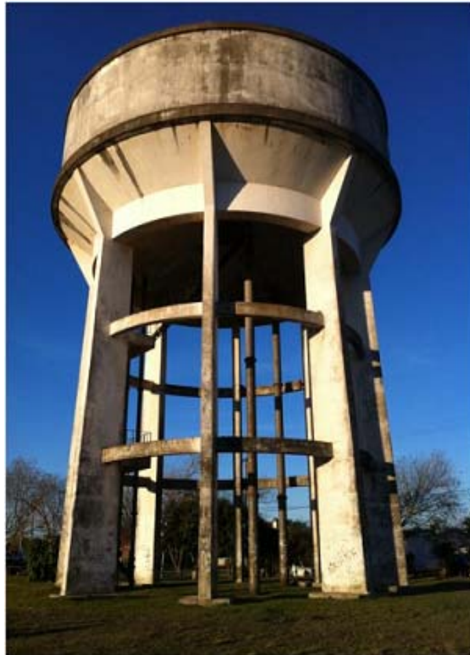
Ilustração 010 – Vista frontal do Reservatório R10.
