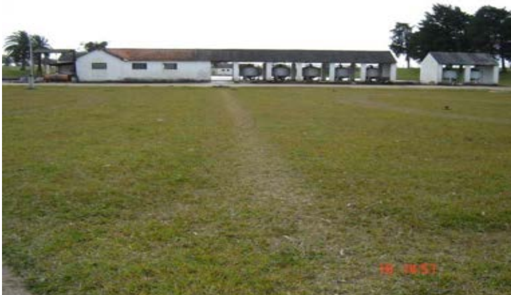
Ilustração 28 - Local do reservatório enterrado com 8.000m 3
