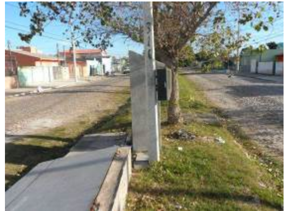
Quadro de comando ELE – Fátima. (Fonte SANEP)
