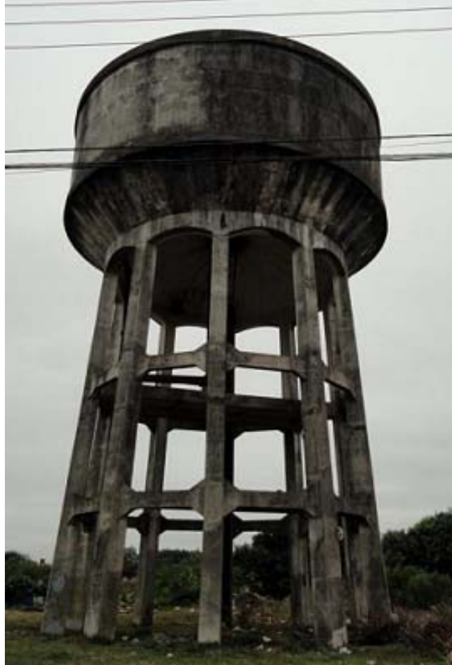
Ilustração 05 – Vista frontal do Reservatório R7.
