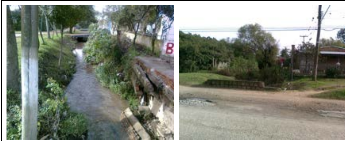
Figura 19: Avenida Domingos de Almeida - Obelisco
