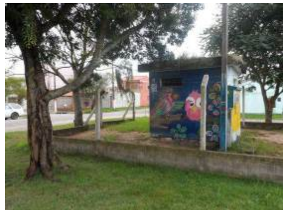
Quadro de comando ELE – Umuharama. (Fonte SANEP)
