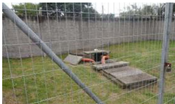
Local da Elevatória Cohab Lindóia. (Fonte SANEP)
