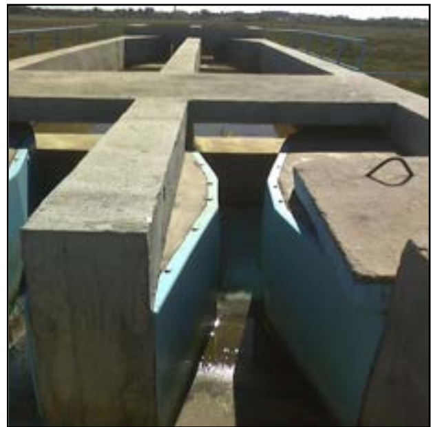
Figura 27 - Calhas Parshall (Fonte STE)
