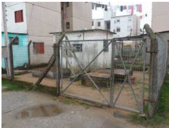
Local da Elevatória Cohab Pestano. (Fonte SANEP)
