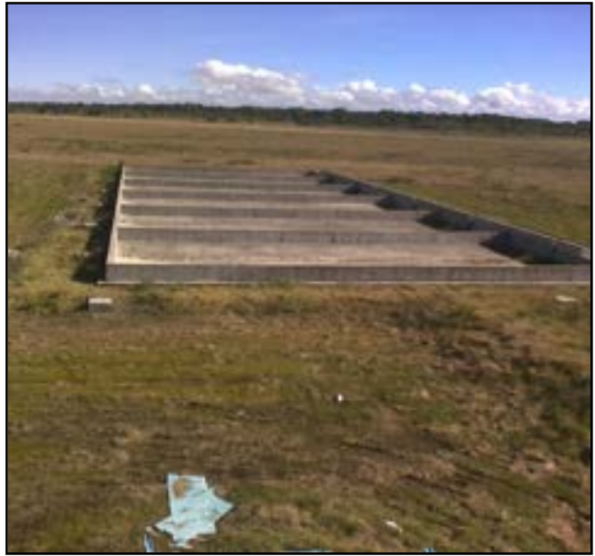
Figura 33 - Leitos de secagem de lodo (Fonte STE)
