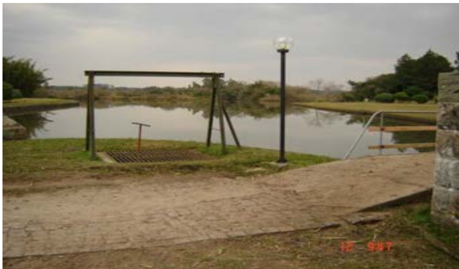
Ilustração 3 - Tomada de água bruta ETA Moreira
