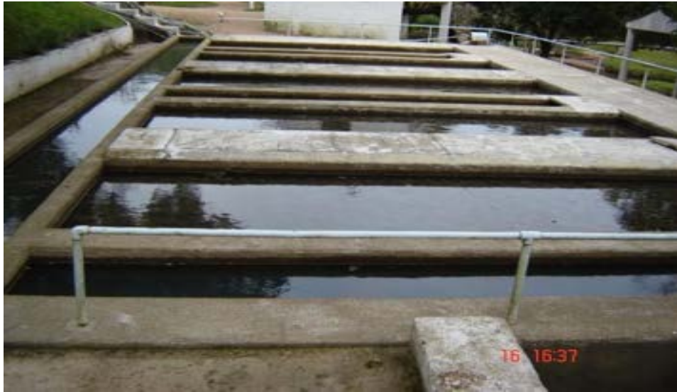
Ilustração 20 - Conjunto de pequenos tanques de filtração
