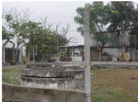
Entrada da ELE – Ceval. (Fonte SANEP)
