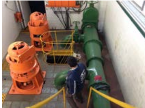
Sistema de bombas ELE – US-I (Fonte STE)
