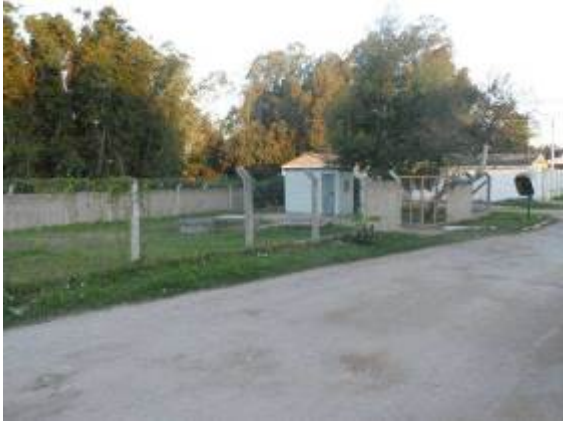
Local da Elevatória Cohab Fragata. (Fonte SANEP)
