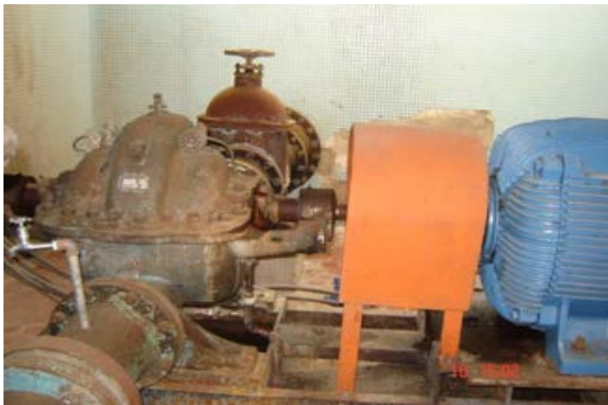
Ilustração 32- Conjunto motobomba 4ª EEAT
