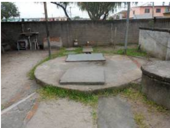
Local da Elevatória Guabiroba . (Fonte SANEP)
