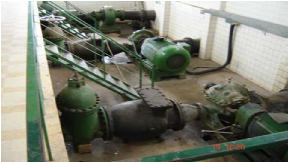
Ilustração 48 - Vista parcial da casa de bombas
