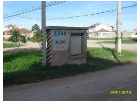
Quadro de comando ELE – L3. (Fonte SANEP)
