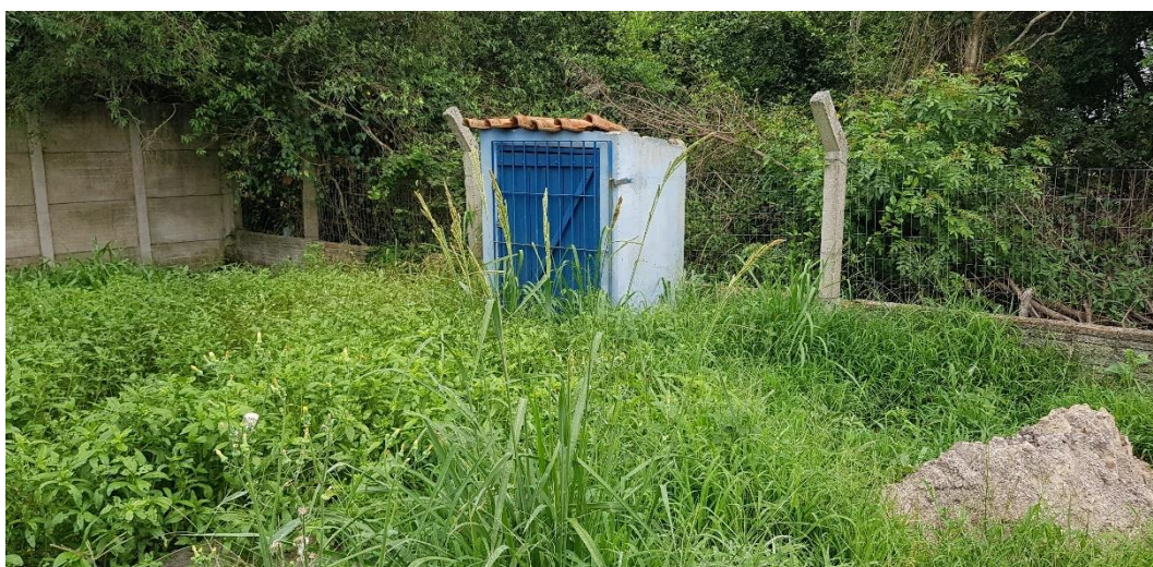
Figura 200 – Estação Elevatória Vila Judite. Fonte: Biancade Engenharia
