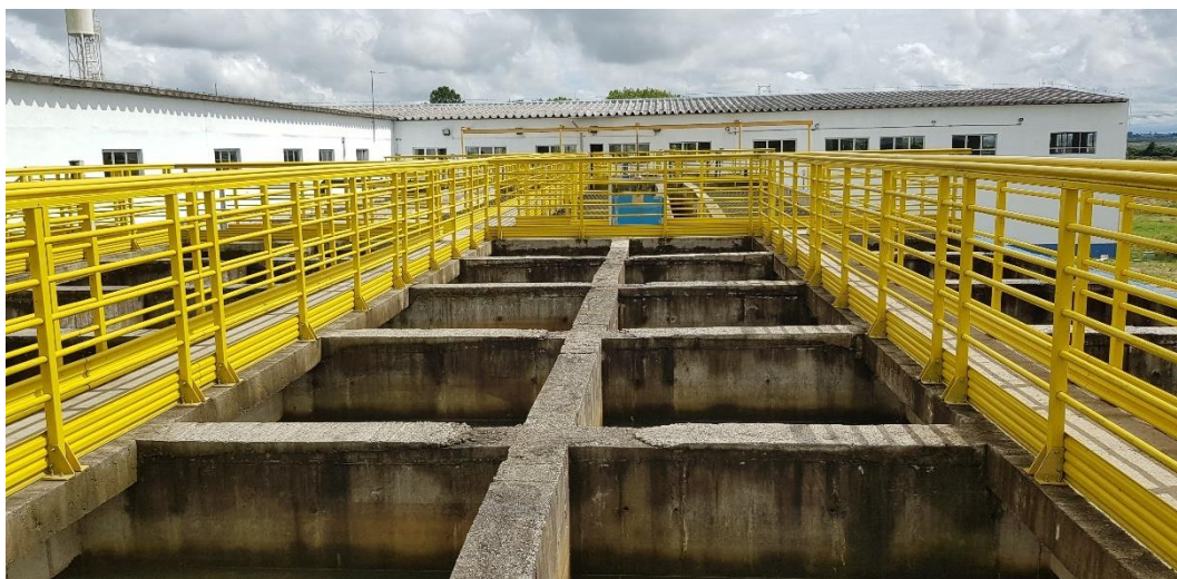
Figura 79 – Decantadores. Fonte: Biancade Engenharia
