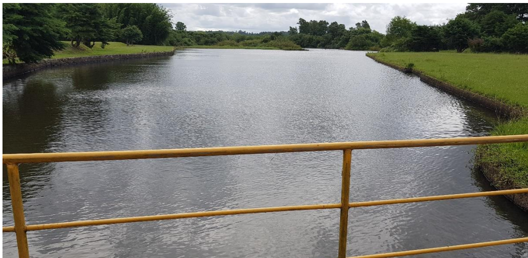
Figura 17 – Represa do Arroio Moreira. Fonte: Biancade Engenharia
