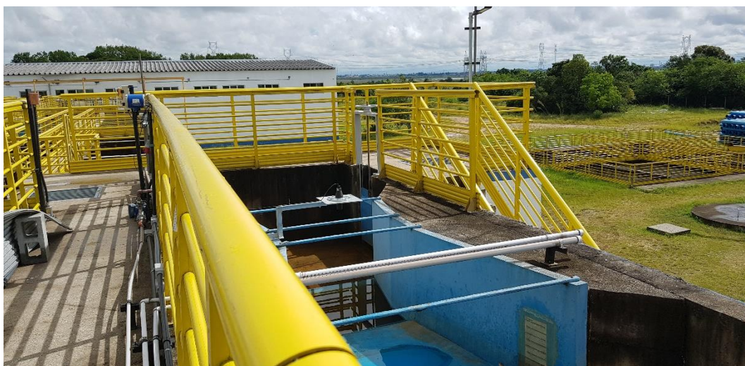
Figura 74 – Calha Parshall. Fonte: Biancade Engenharia
