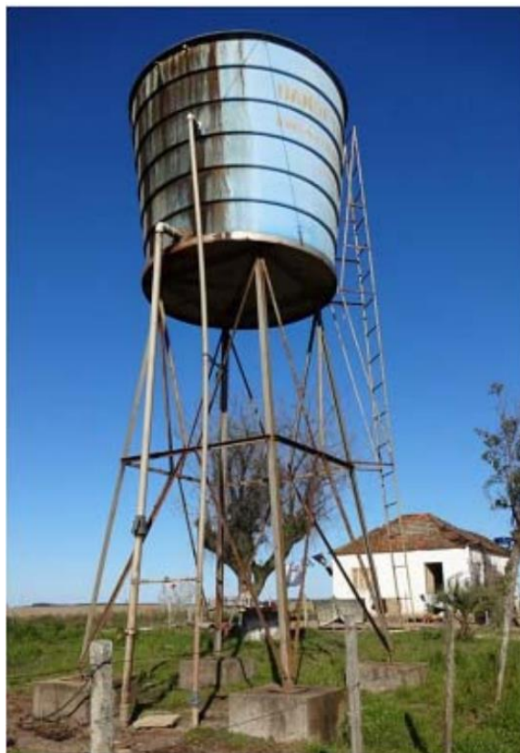
Figura 142 – Reservatório Posto Branco do Município. Fonte: PDA, 2014
