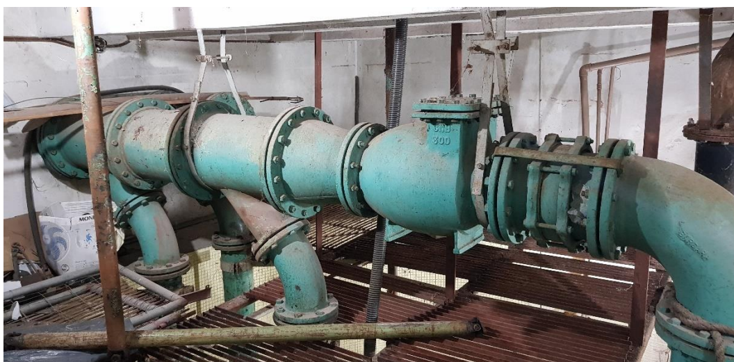
Figura 154 – ETE Porto – Barrilete do Recalque. Fonte: Biancade Engenharia
