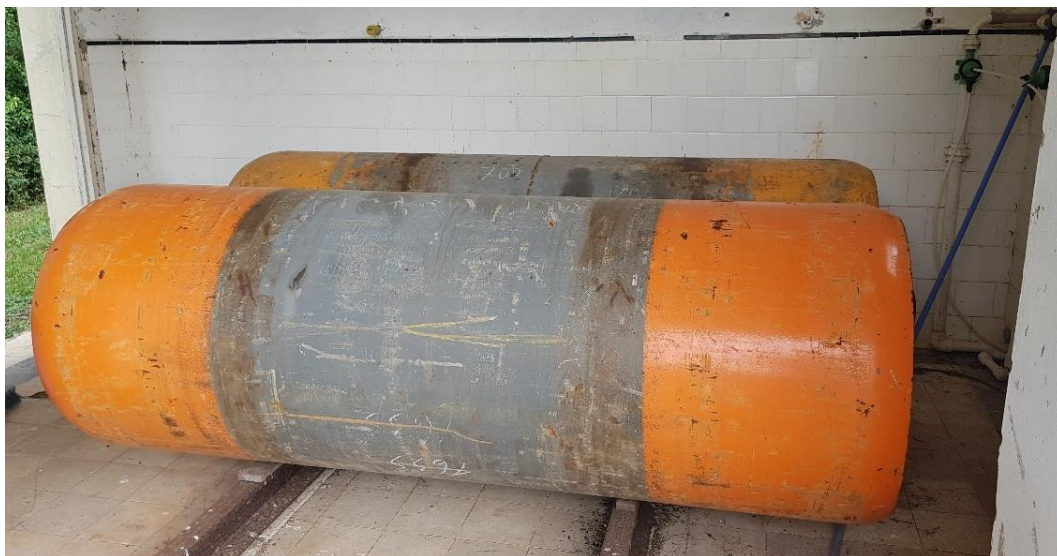
Figura 37 – Cilindros de Cloro. Fonte: Biancade Engenharia
