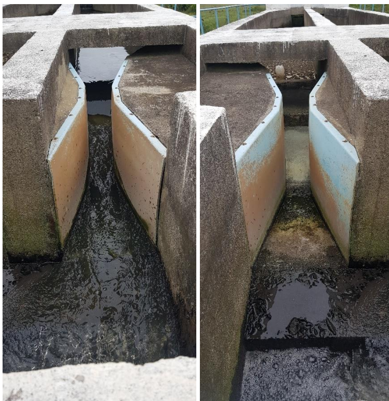
Figura 157 – ETE Laranjal – Calhas de Distribuição de Esgoto Bruto. Fonte: Biancade Engenharia
