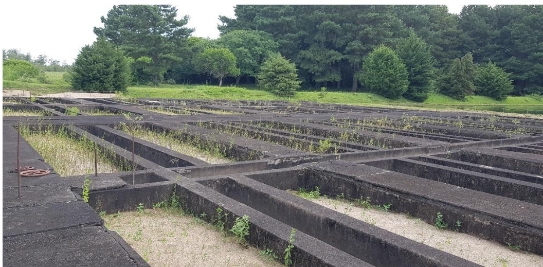
Figura 35 – Antigos Filtros Horizontais. Fonte: Biancade Engenharia
