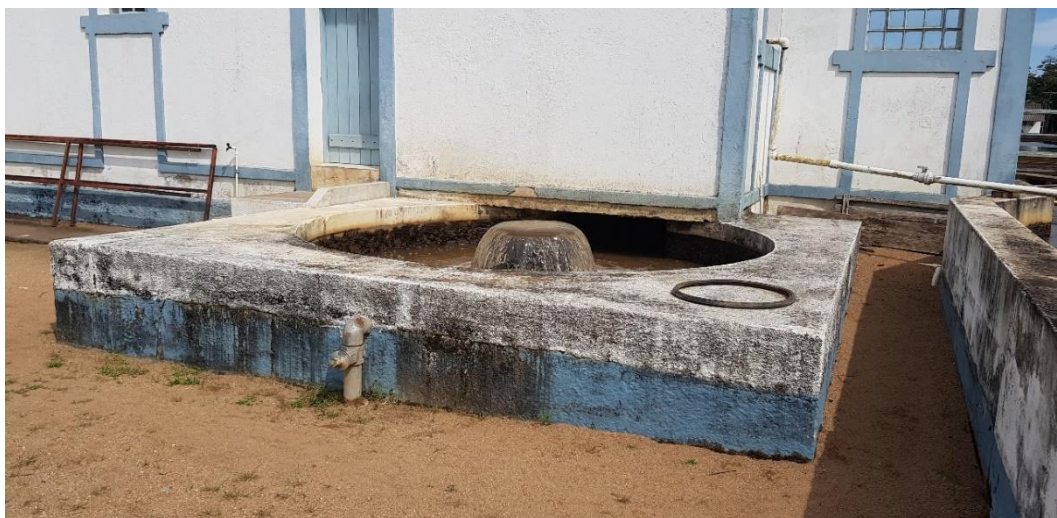
Figura 59 – Canal de Entrada da Água Bruta na ETA. Fonte: Biancade Engenharia
