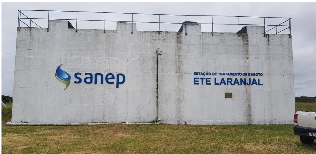
Figura 155 – ETE Laranjal – Reator Anaeróbio. Fonte: Biancade Engenharia
