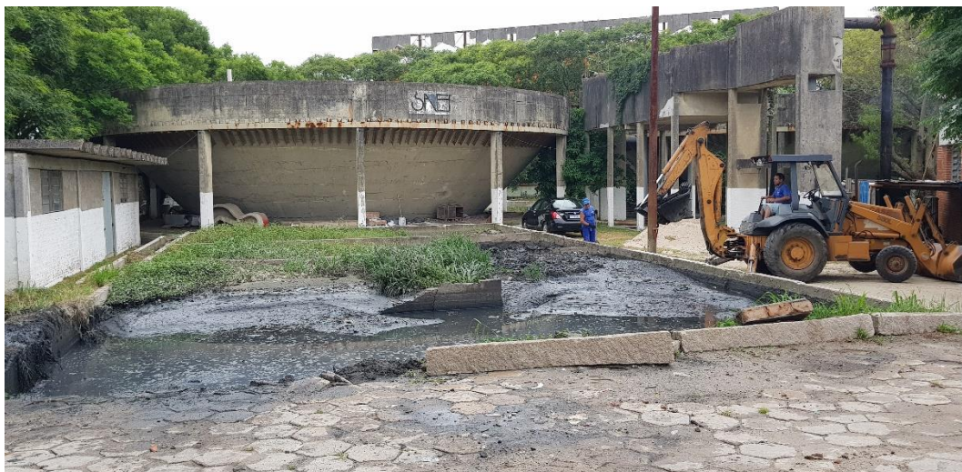
Figura 150 – ETE Porto – Estrutura de Entrada (Desarenador e Calha Parshall. Fonte: Biancade Engenharia
