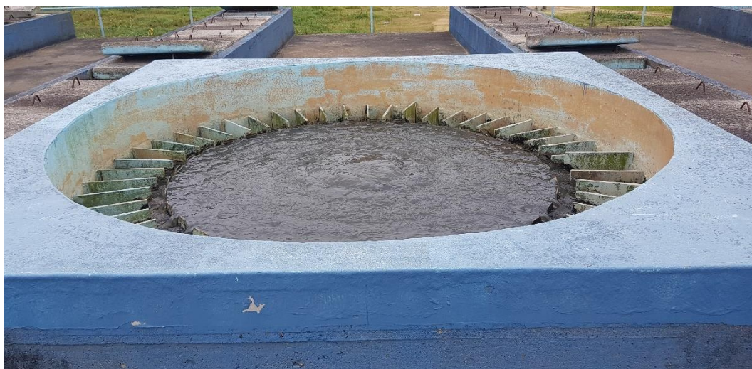
Figura 157 – ETE Laranjal – Calhas de Distribuição de Esgoto Bruto. Fonte: Biancade Engenharia
