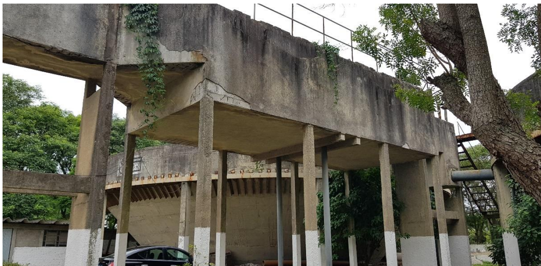
Figura 150 – ETE Porto – Estrutura de Entrada (Desarenador e Calha Parshall. Fonte: Biancade Engenharia
