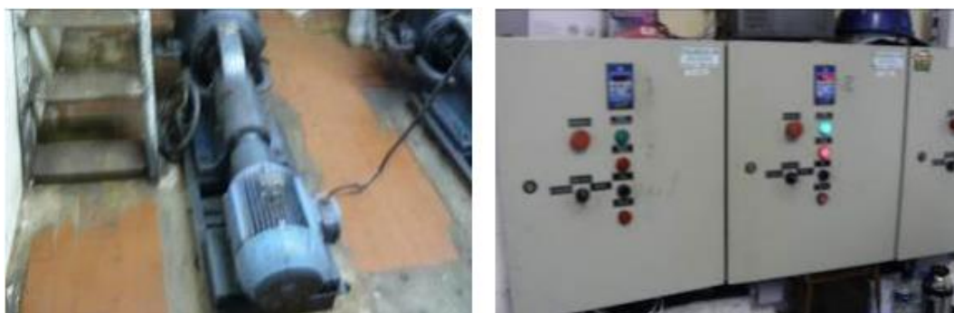
Figura 222 – EEE US-II – Motobomba e Quadro de Comandos. Fonte: PDE, 2011
