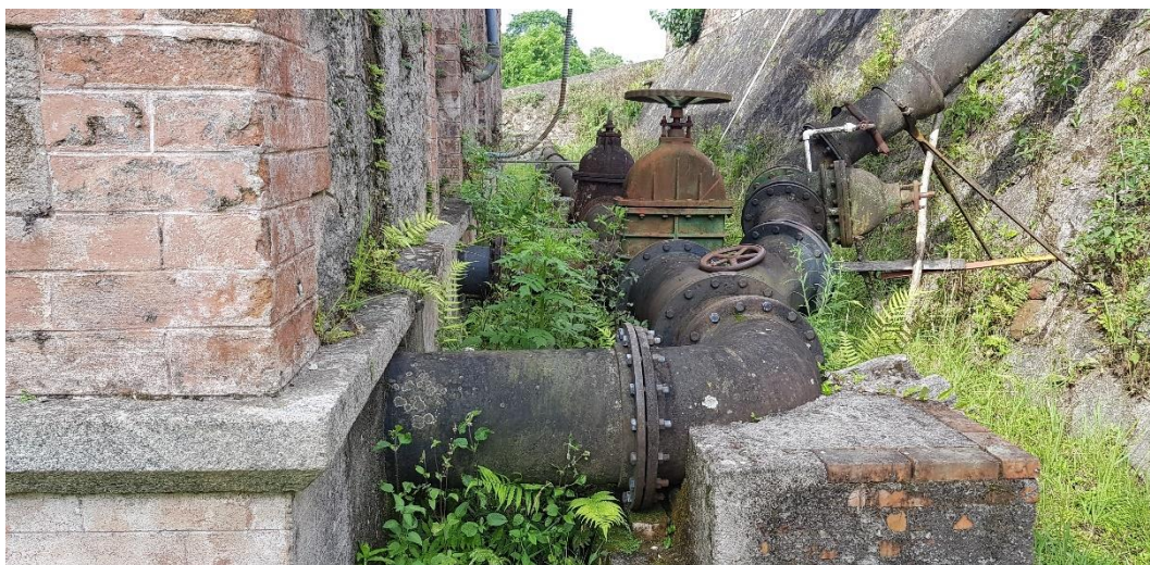
Figura 88 – Adutora Existente no Município. Fonte: Biancade Engenharia
