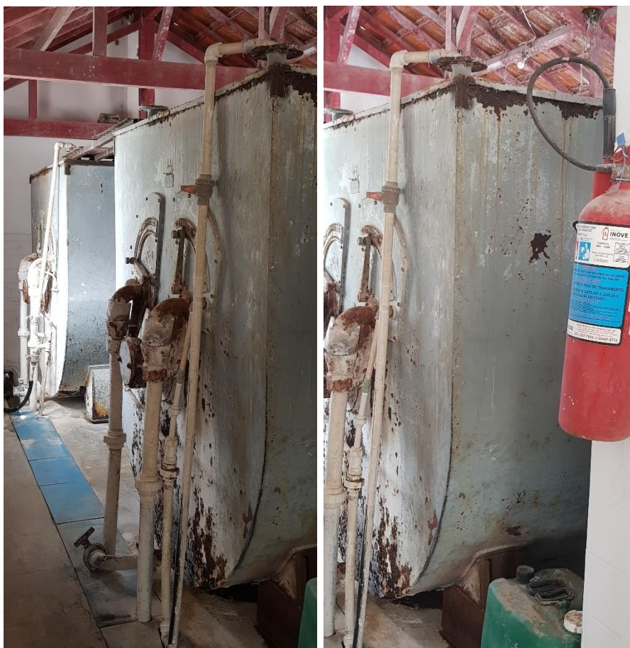
Figura 69 – Tanques de Flúor da ETA Sinnot. Fonte: Biancade Engenharia
