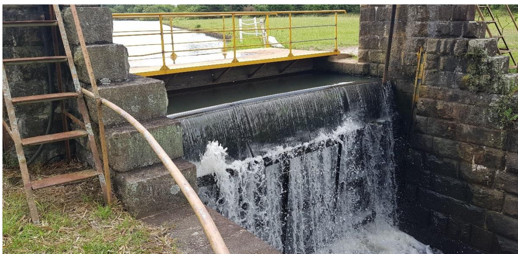
Figura 19 – Comporta Represa do Moreira. Fonte: Biancade Engenharia
