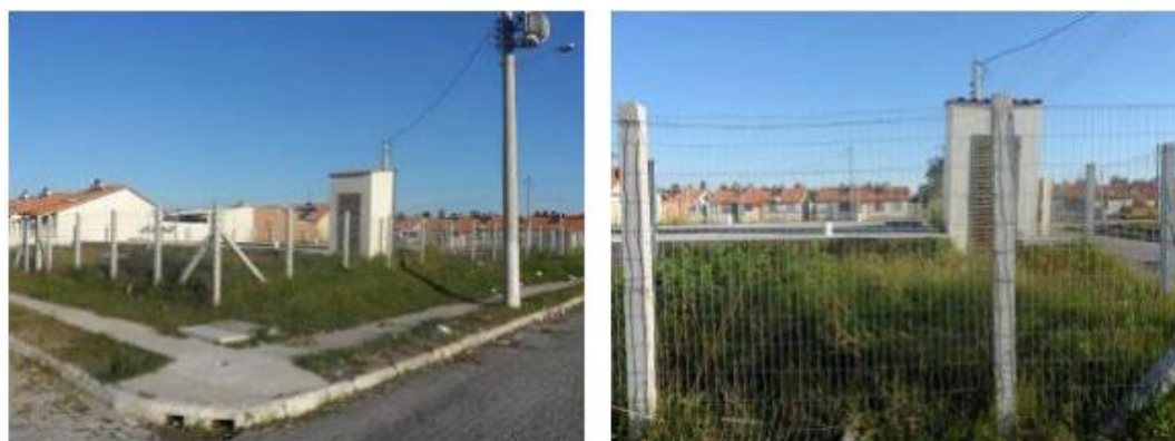
Figura 218 – EEE Eldorado – Estação Elevatória Eldorado. Fonte: PDE, 2011
