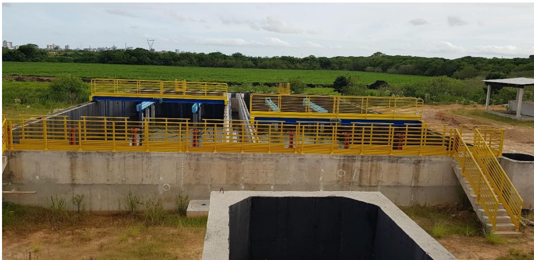
Figura 168 – ETE Novo Mundo – Decantadores. Fonte: Biancade Engenharia
