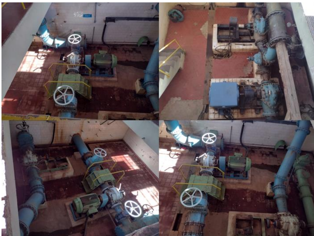
Figura 22 – Vistas dos Conjuntos Motobomba
