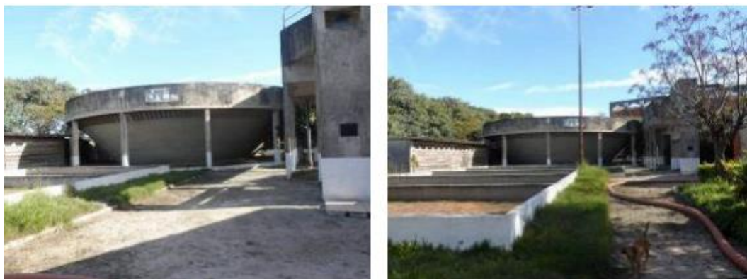
Figura 225 – EEE US-III – Estação Elevatória US-III. Fonte: PDE, 2011
