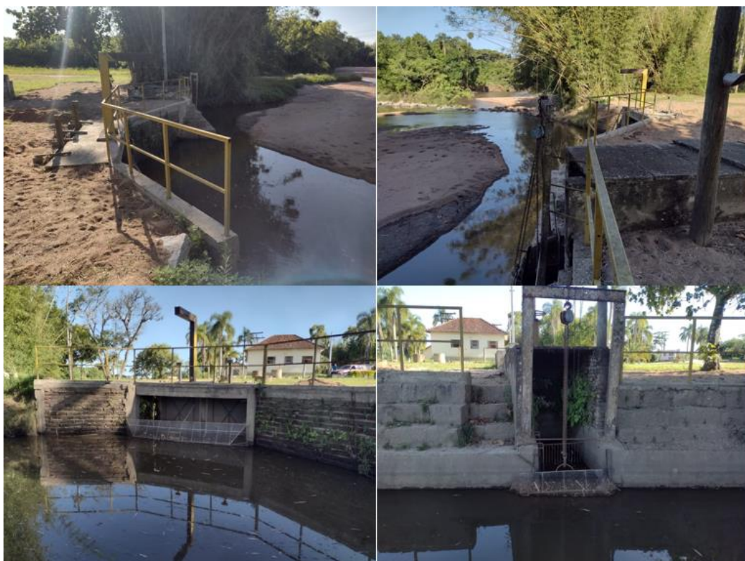
Figura 20 – Tomada de Água Arroio Pelotas. Fonte: PDA, 2014
