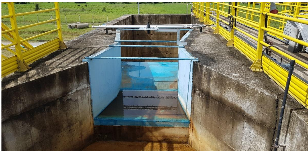
Figura 74 – Calha Parshall. Fonte: Biancade Engenharia
