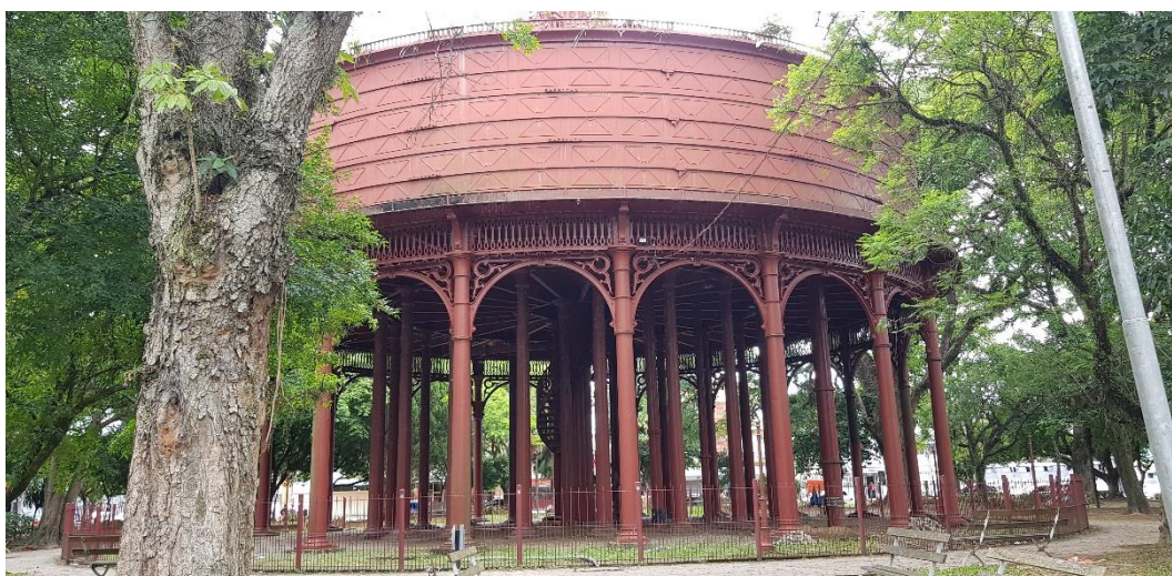
Figura 114 – Reservatório R-01 do Município. Fonte: Biancade Engenharia
