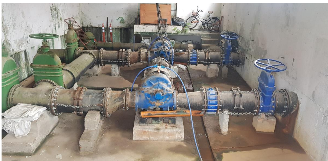
Figura 121 – Conjunto Motobombas do R-08T. Fonte: Biancade Engenharia
