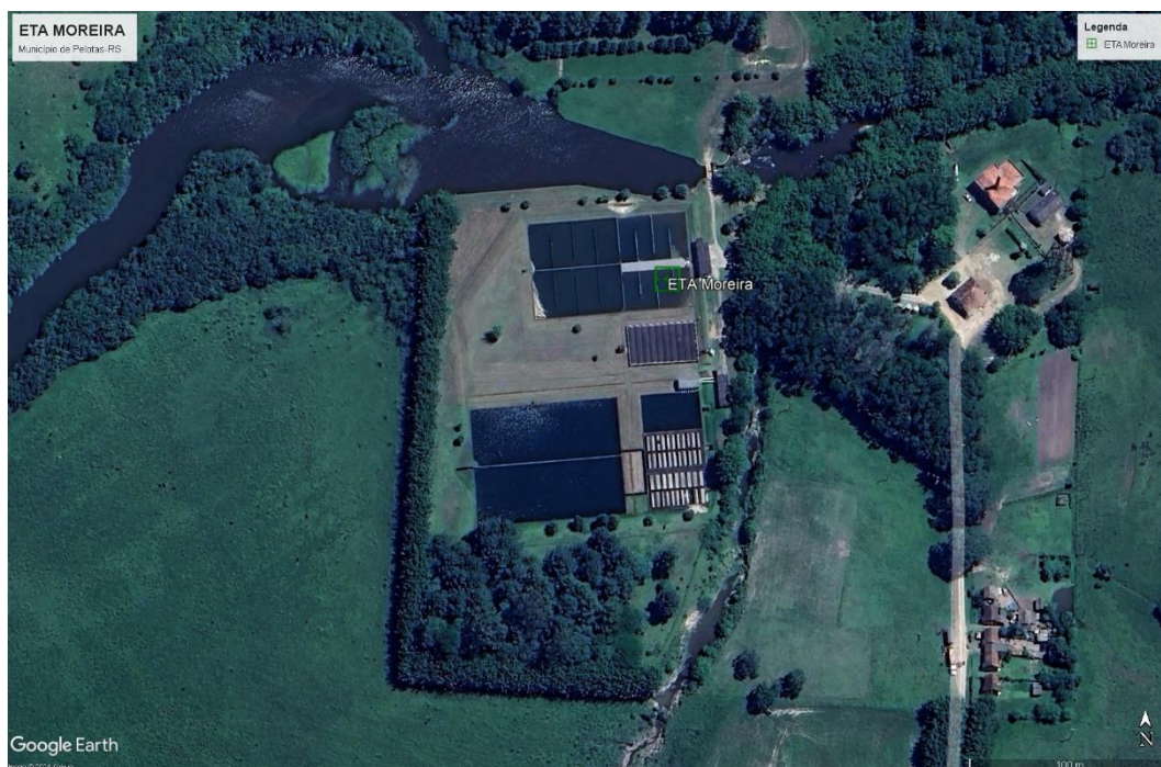
Figura 31 – Localização da ETA Moreira. Fonte: Google Earth
