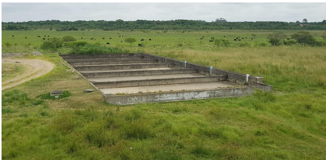
Figura 160 – ETE Laranjal – Leitos de Secagem de Lodo. Fonte: Biancade Engenharia
