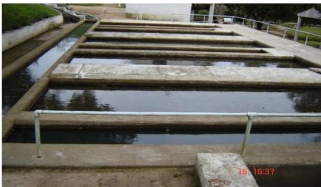
Figura 24 – Conjunto de Pequenos Tanques de Filtragem. Fonte: PDA, 2014
