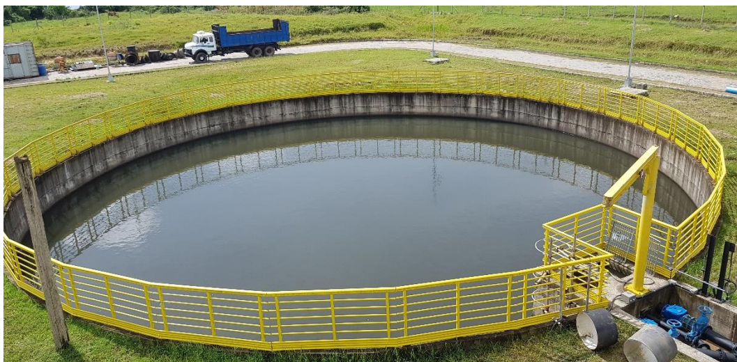
Figura 77 – Adensador. Fonte: Biancade Engenharia
