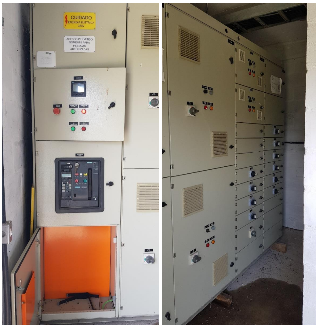
Figura 30 – Quadro de Comandos. Fonte: Biancade Engenharia
