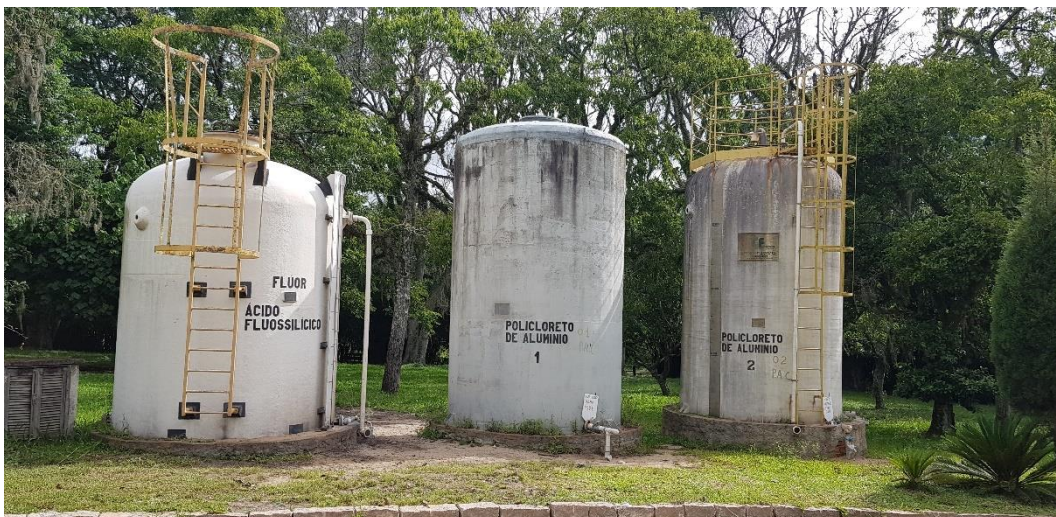
Figura 39 – Tanques de Fluor e PAC . Fonte: Biancade Engenharia
