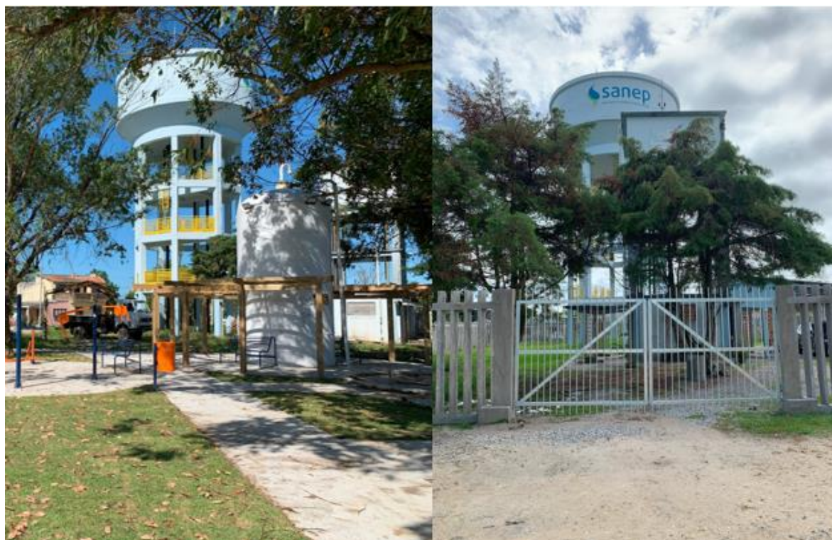
Figura 133 – Reservatório R-11 e R11T do Município
