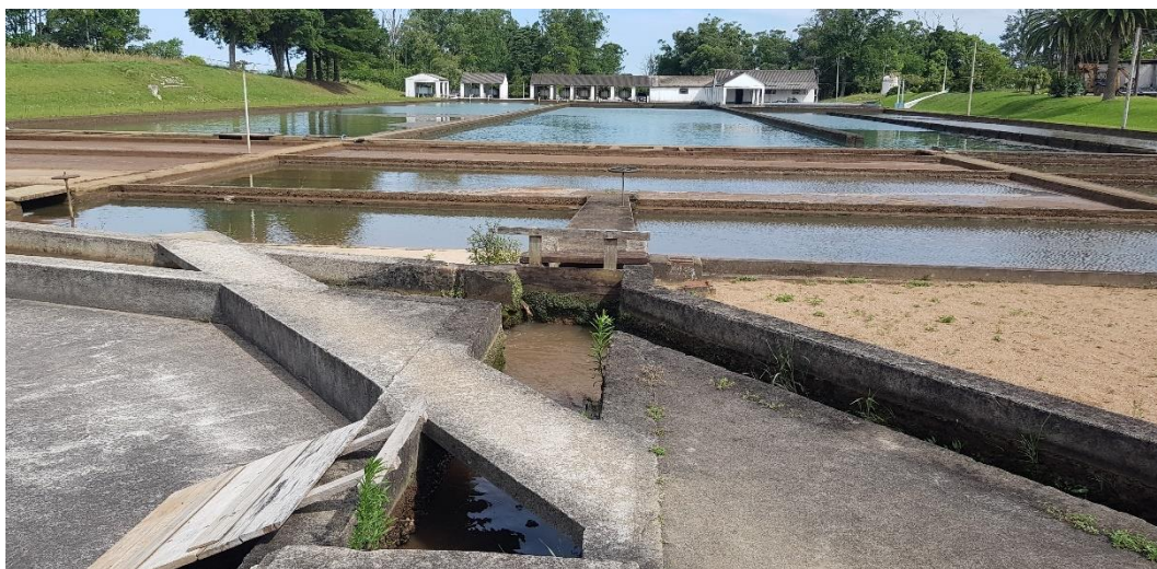
Figura 63 – Decantadores da Estação de Tratamento. Fonte: Biancade Engenharia
