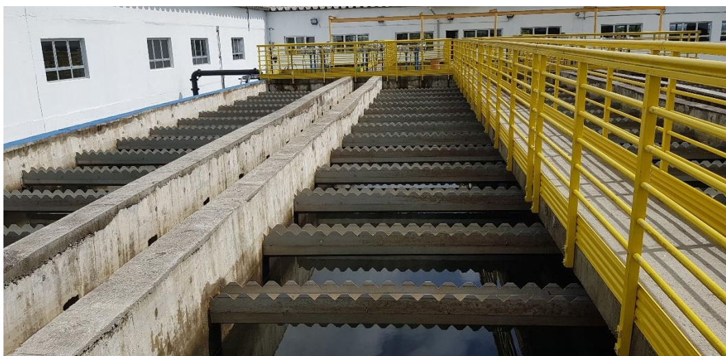
Figura 79 – Decantadores. Fonte: Biancade Engenharia
