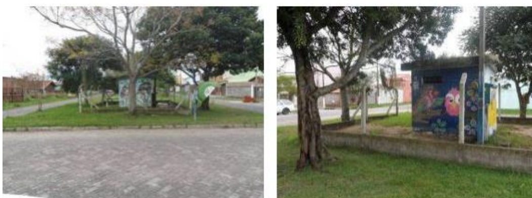
Figura 209 – EEE Umuharama – Estação Elevatória Umuharama. Fonte: PDE, 2011
