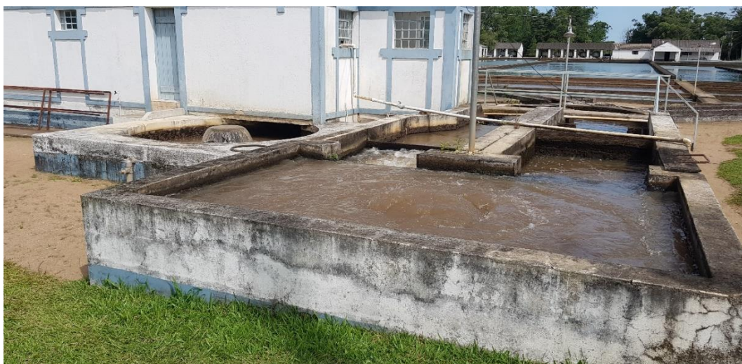
Figura 59 – Canal de Entrada da Água Bruta na ETA. Fonte: Biancade Engenharia
