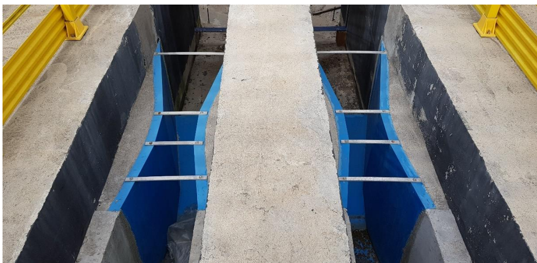
Figura 164 – ETE Novo Mundo – Calhas Parshall. Fonte: Biancade Engenharia
