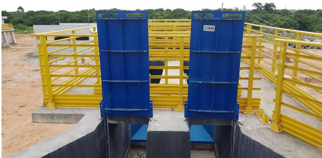
Figura 166 – ETE Novo Mundo – Comportas (Gates). Fonte: Biancade Engenharia
