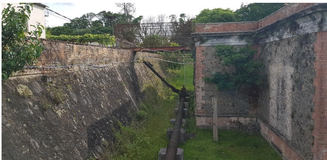
Figura 88 – Adutora Existente no Município. Fonte: Biancade Engenharia
