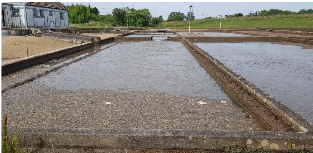
Figura 63 – Decantadores da Estação de Tratamento. Fonte: Biancade Engenharia
