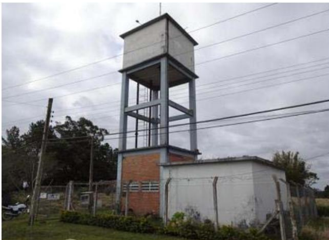
Figura 138 – Reservatório MB-2 do Município. Fonte: PDA, 2014
