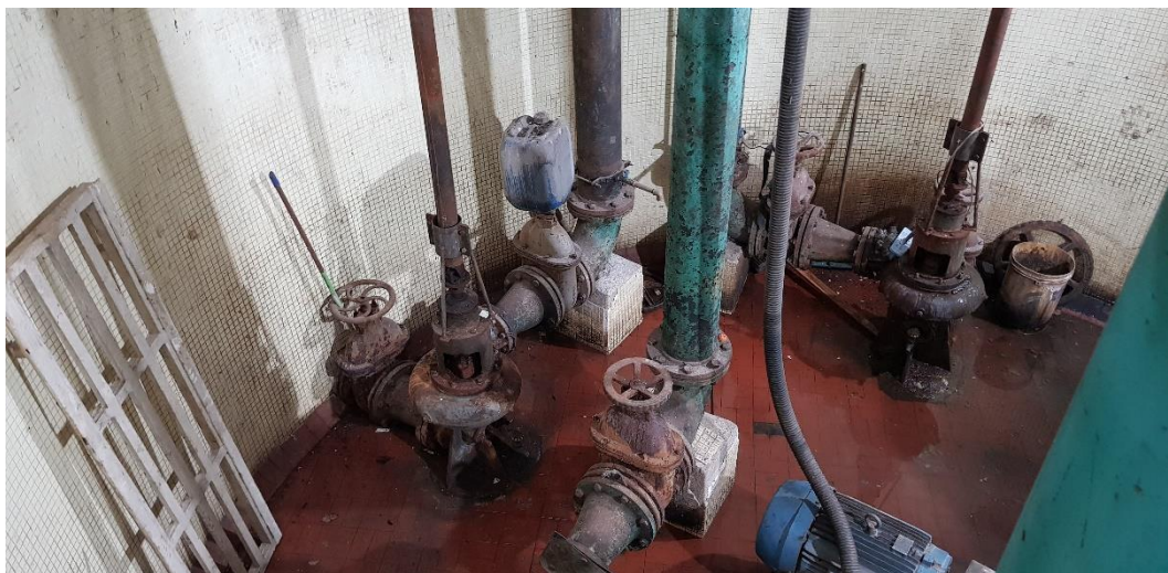
Figura 152 – ETE Porto – Conjunto Mobomba Existente na ETE. Fonte: Biancade Engenharia
