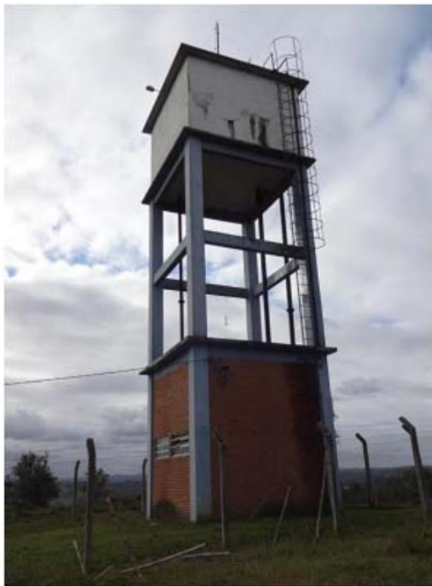
Figura 140 – Reservatórios para regularização de vazão. Fonte: PDA, 2014
