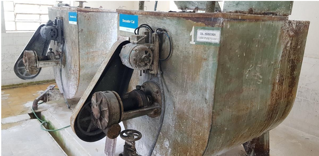
Figura 39 – Tanques de Fluor e PAC . Fonte: Biancade Engenharia
