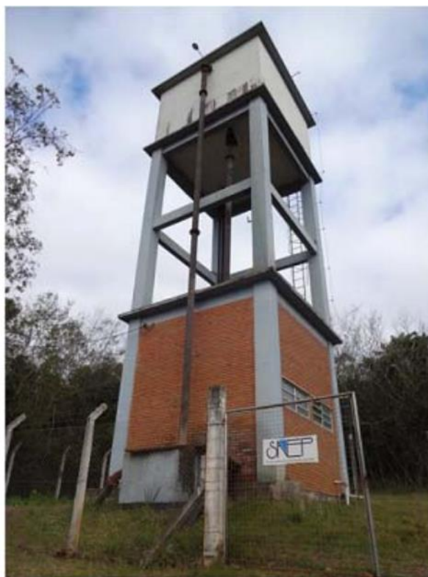
Figura 137 – Reservatório MB-1 do Município. Fonte: PDA, 2014
