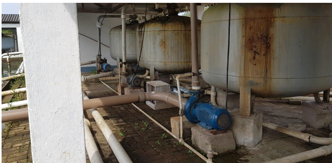
Figura 69 – Tanques de Flúor da ETA Sinnot. Fonte: Biancade Engenharia
