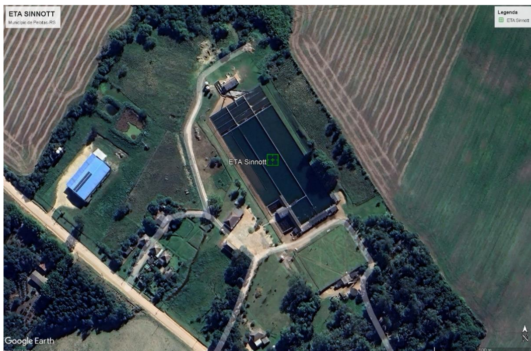
Figura 57 – Localização da ETA Sinnott. Fonte: Google Earth
