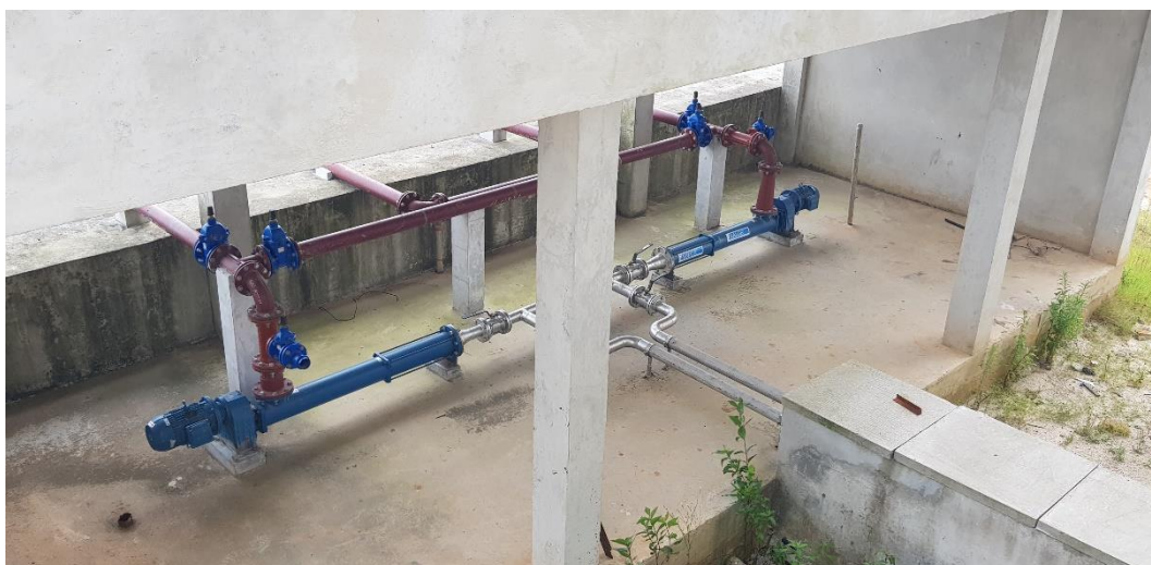
Figura 170 – ETE Novo Mundo – Bombas e Barriletes. Fonte: Biancade Engenharia
