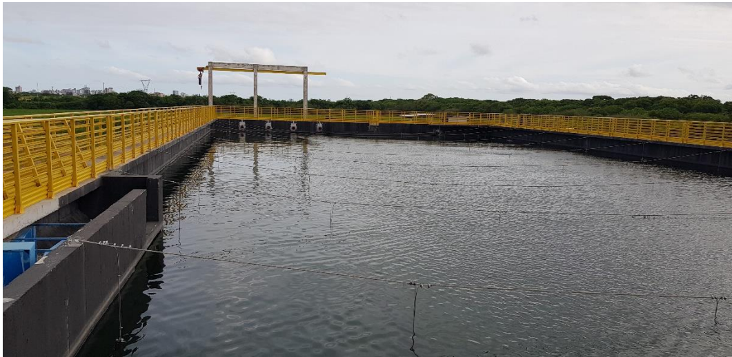
Figura 168 – ETE Novo Mundo – Decantadores. Fonte: Biancade Engenharia
