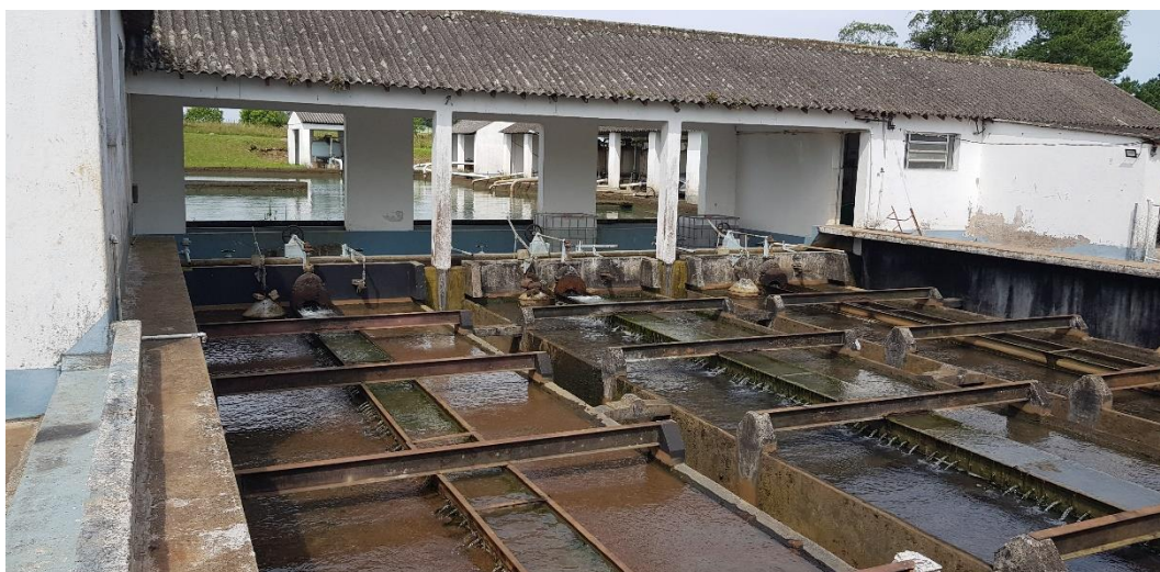
Figura 65 – Filtros de Areia da Estação de Tratamento. Fonte: Biancade Engenharia
