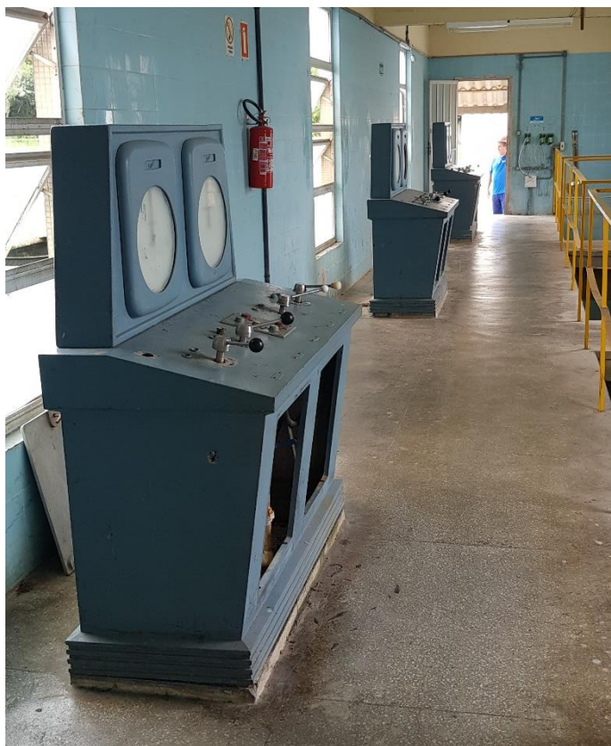
Figura 49 – Bancada de Operação para Limpeza dos Filtros. Fonte: Biancade Engenharia
