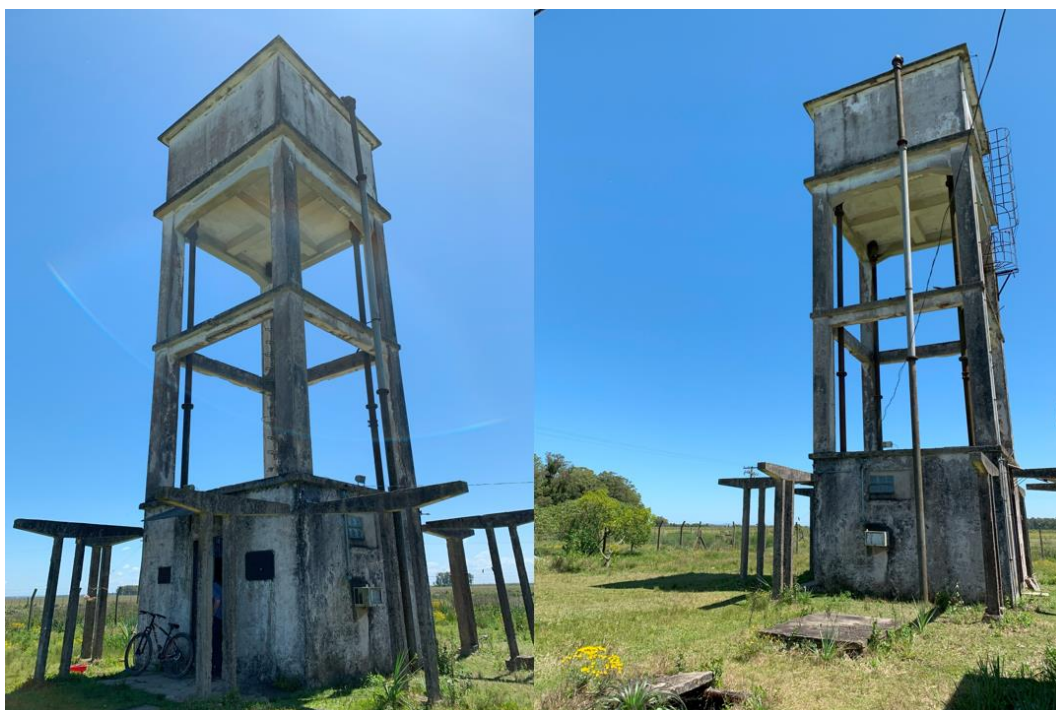
Figura 134 – Reservatório R-13 Elevado do Município. Fonte: PDA, 2014
