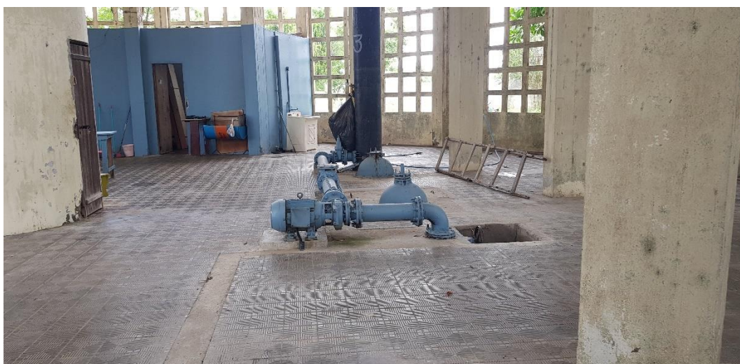
Figura 116 – Conjunto Motobomba R-03 do Município. Fonte: PDA, 2014
