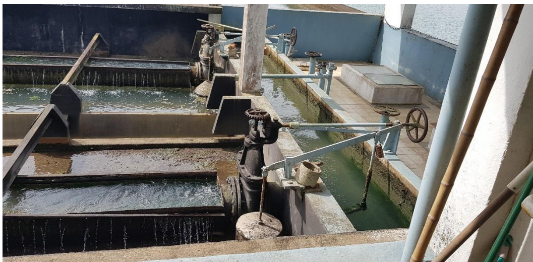
Figura 65 – Filtros de Areia da Estação de Tratamento. Fonte: Biancade Engenharia
