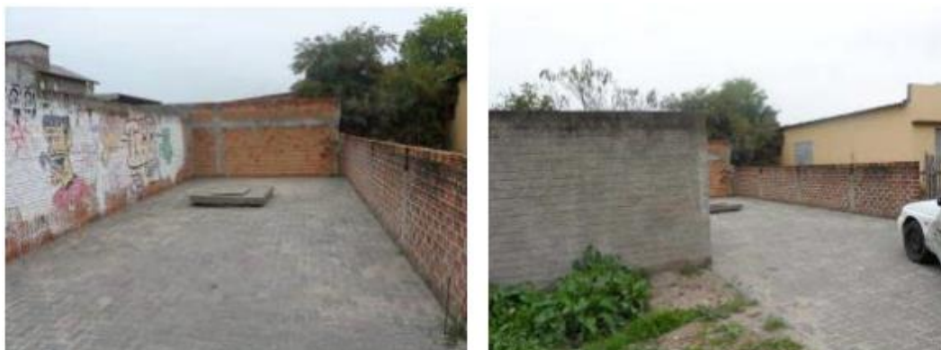
Figura 223 – EEE Toussaint – Estação Elevatória Toussaint. Fonte: PDE, 2011
