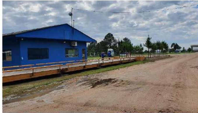
Figura 9. Estação de Transbordo.
