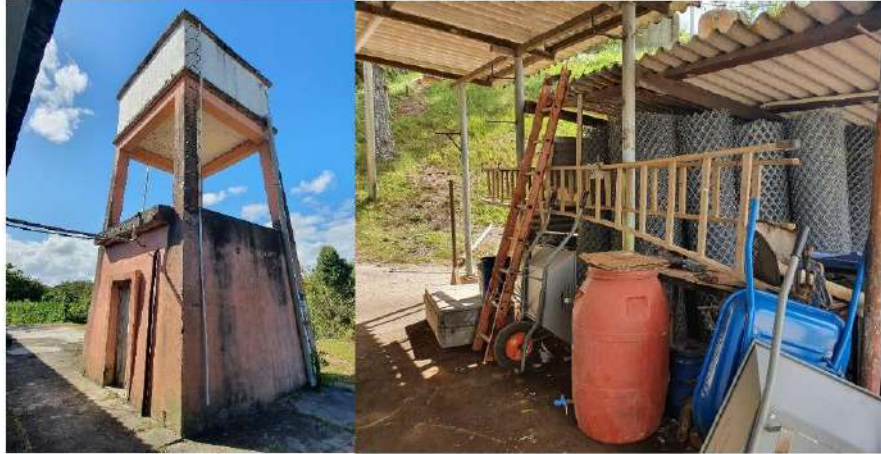
Figuras 49 e 50. Locais para armazenamento temporário de resíduos químicos de laboratório e para vidrarias e lâmpadas quebradas, respectivamente – Barragem Santa Bárbara.
