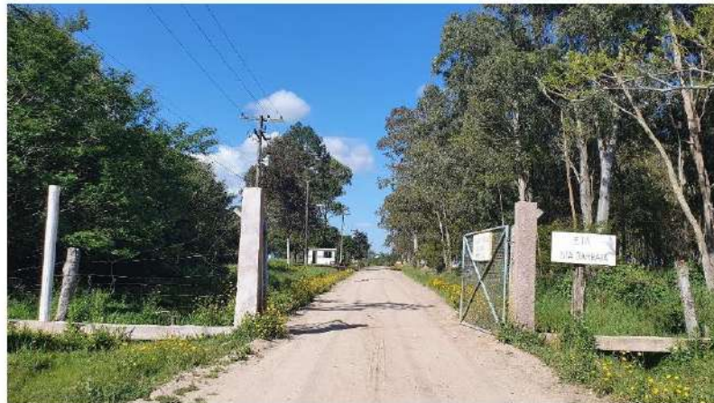
Figura 10. Entrada para Barragem Santa Bárbara.
