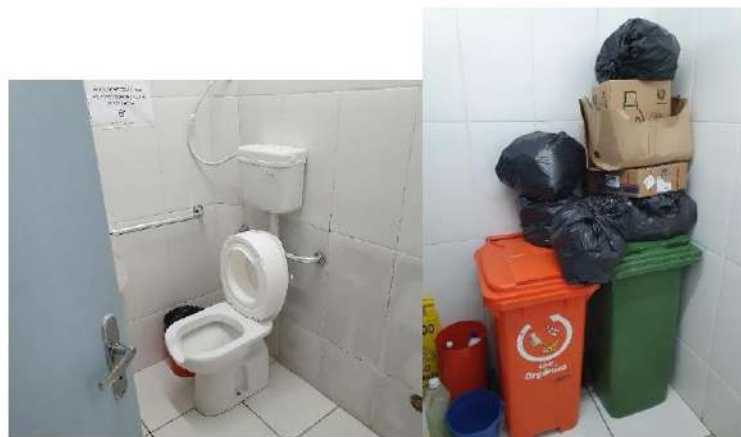
Figuras 41 e 42. Banheiro atualmente adotado como local de armazenamento temporário dos resíduos gerados na Unidade Atendimento.
