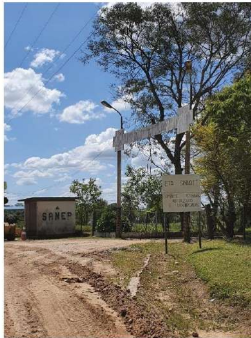
Figura 11. Entrada para a ETA Sinotti.
