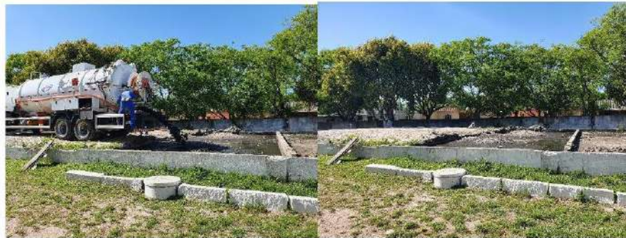
Figuras 67 e 68. Leitos de secagem de lodo de limpeza de galeria de macrodrenagem – RALF.
